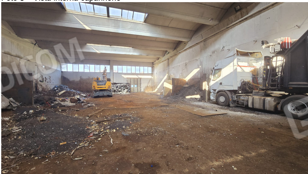
Foto 9 – Vista interna capannone
