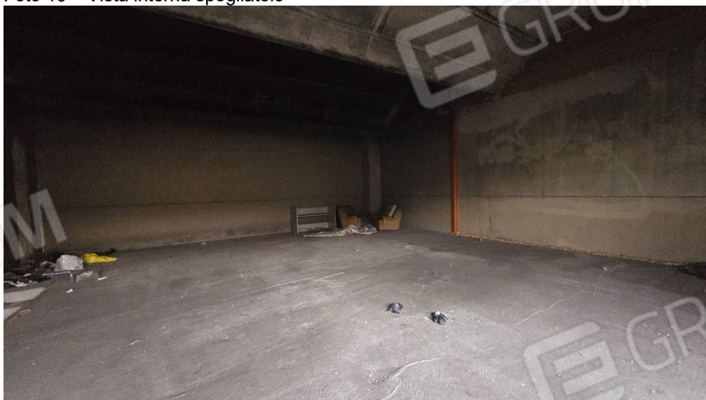
Foto 11 – Vista interna locale piano primo al grezzo
