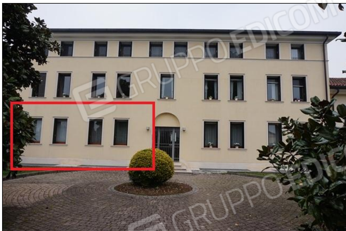
FOTO 3 – Vista fronte sud fabbricato principale
