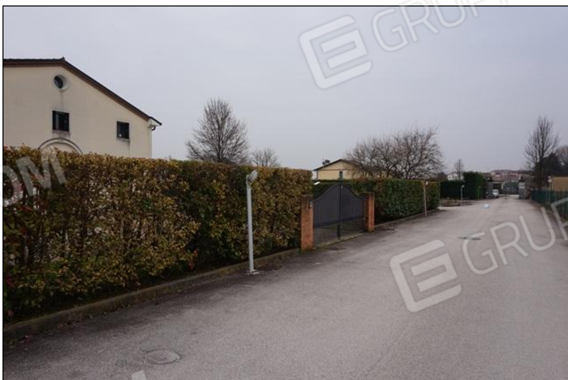
FOTO 2 – Vista corsia pedonale carraia a ovest
