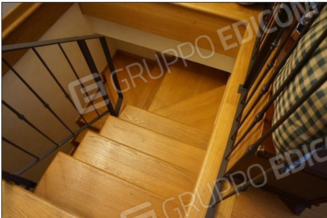
FOTO 27 – Piano Terra – Scala interna accesso piano interrato
