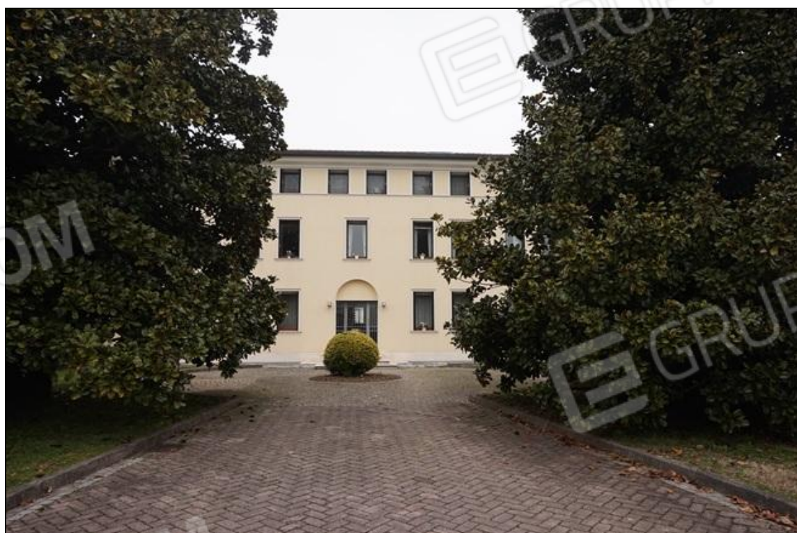
FOTO 4 – Fronte sud fabbricato principale e cortile comune
