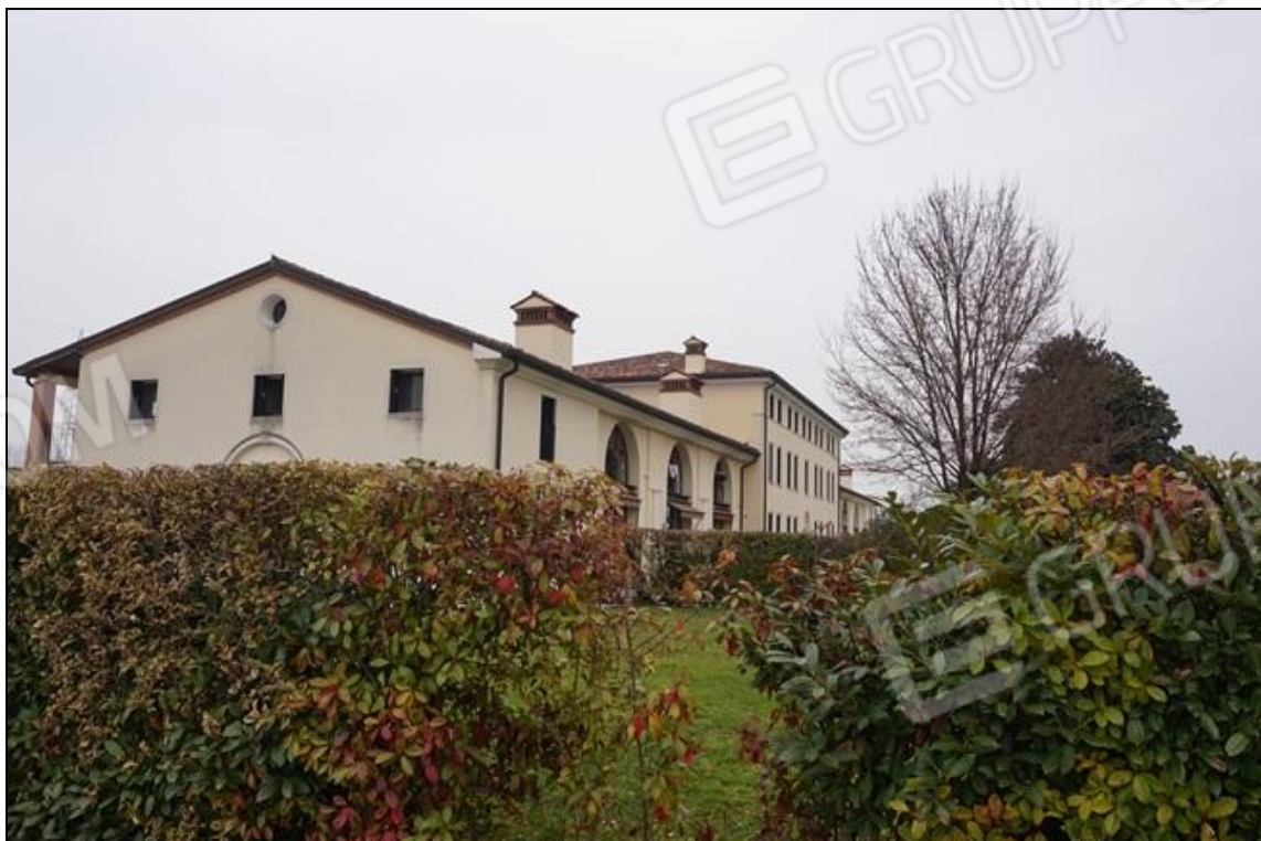
FOTO 8 – Vista fronte ovest fabbricato principale
