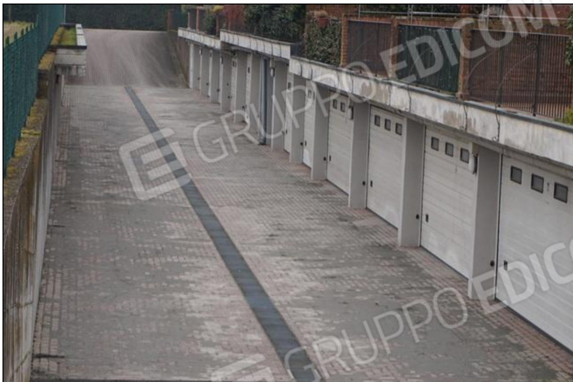
FOTO 35 – Piano interrato – Corsia comune accesso garage
