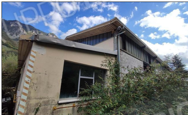
Vista angolo nord-ovest
