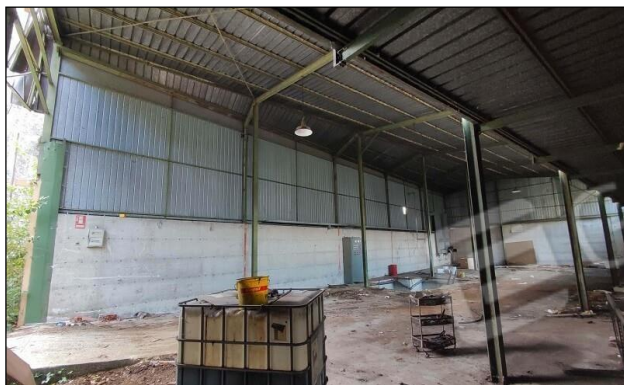
Vista interna immobile F
