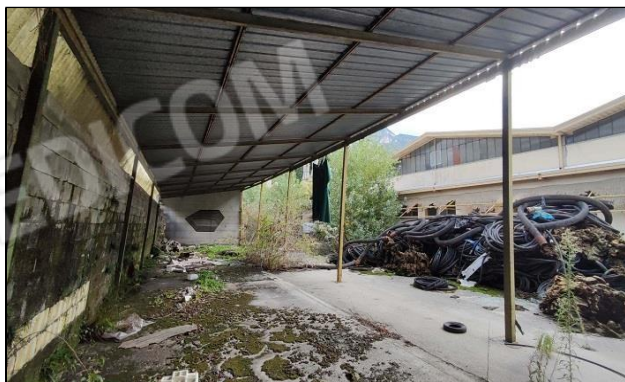
Tettoia confine nord-ovest
