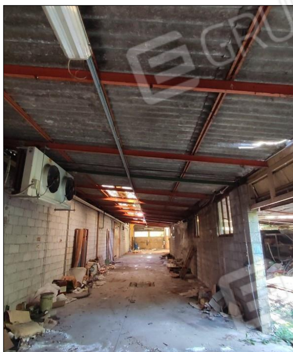
Vista immobile D – officina
