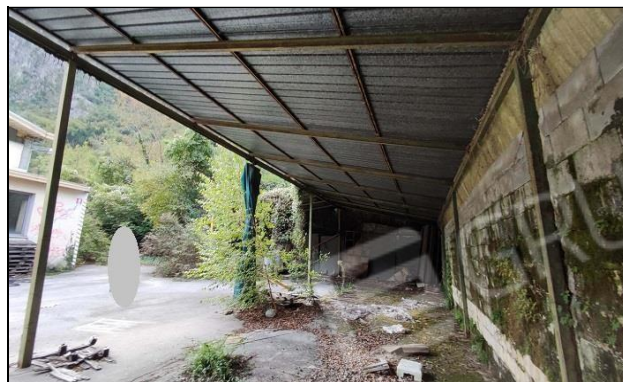
Tettoia confine nord-ovest
