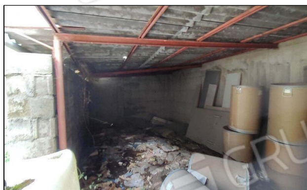
Vista deposito a confine nord-est
