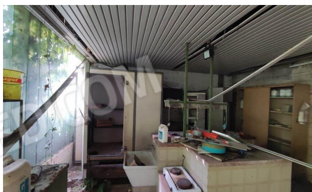
Tettoia precaria lato sud-est
