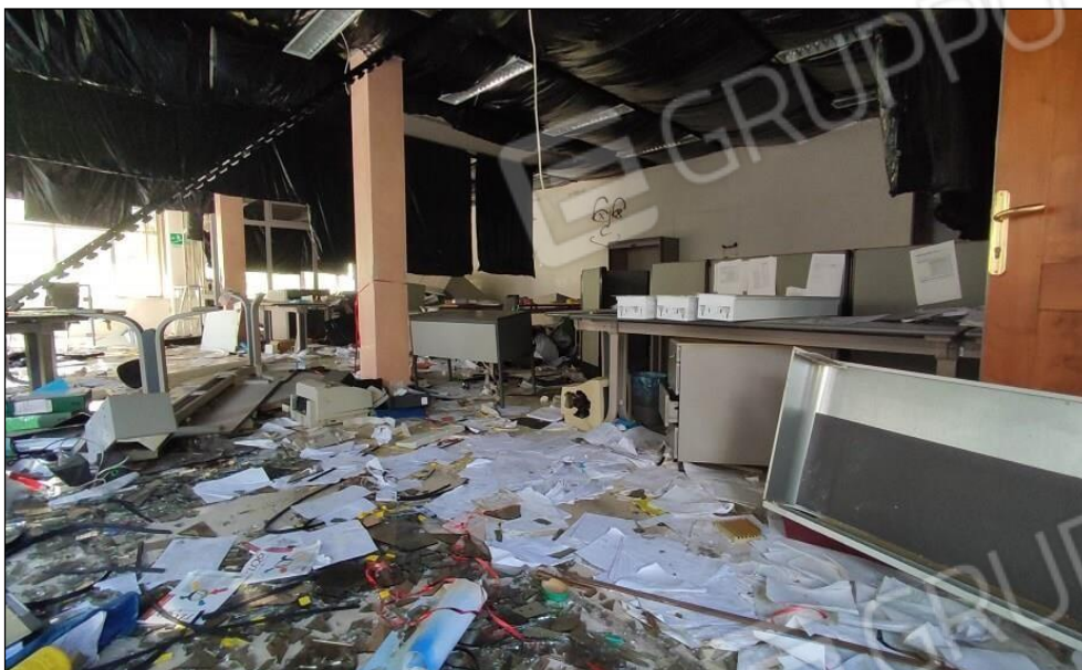
Vista interna degli uffici piano primo
