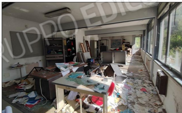
Vista interna degli uffici piano primo
