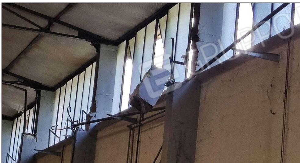
Pari dei pilastri demoliti per asportazione carroponte
