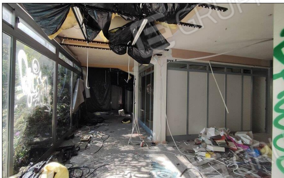
Vista interna degli uffici piano terra
