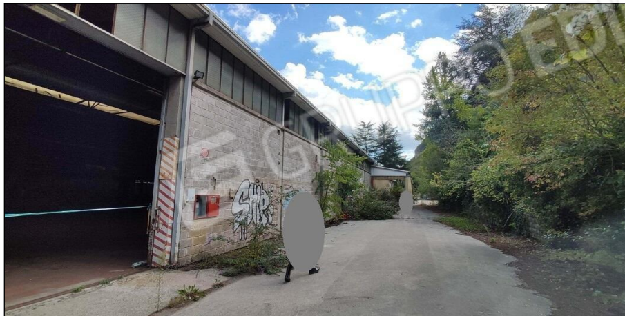
Lato ovest con ingresso al capannone
