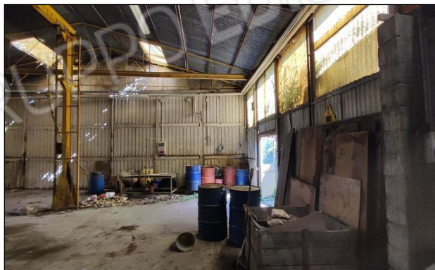
Vista interna immobile E – con rifiuti abbandonati
