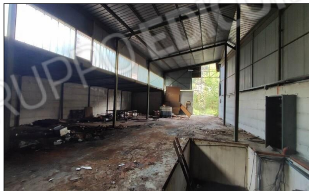
Vista interna immobile F
