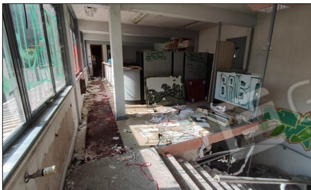
Vista interna degli uffici piano primo
