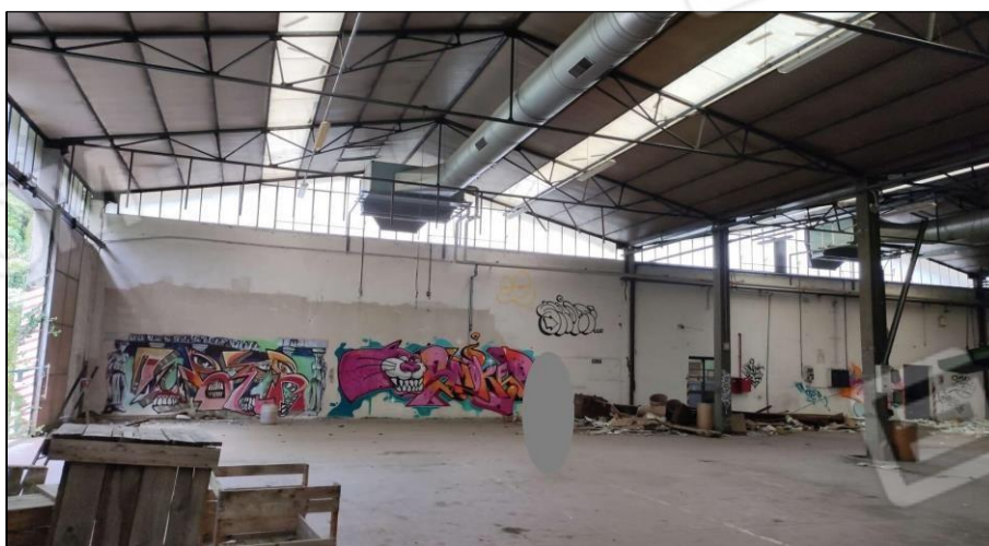
Vista interna capannone
