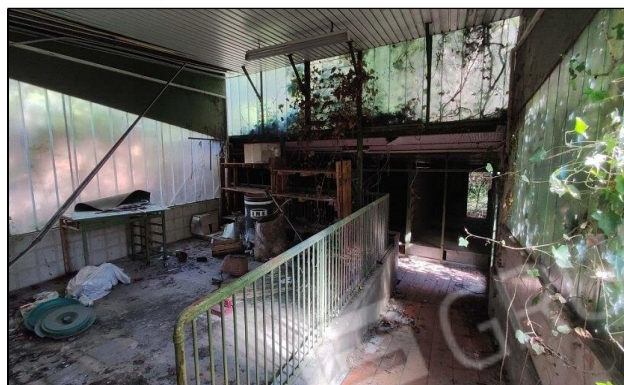
Tettoia precaria lato sud-est
