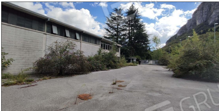
Vista facciata lato ovest
