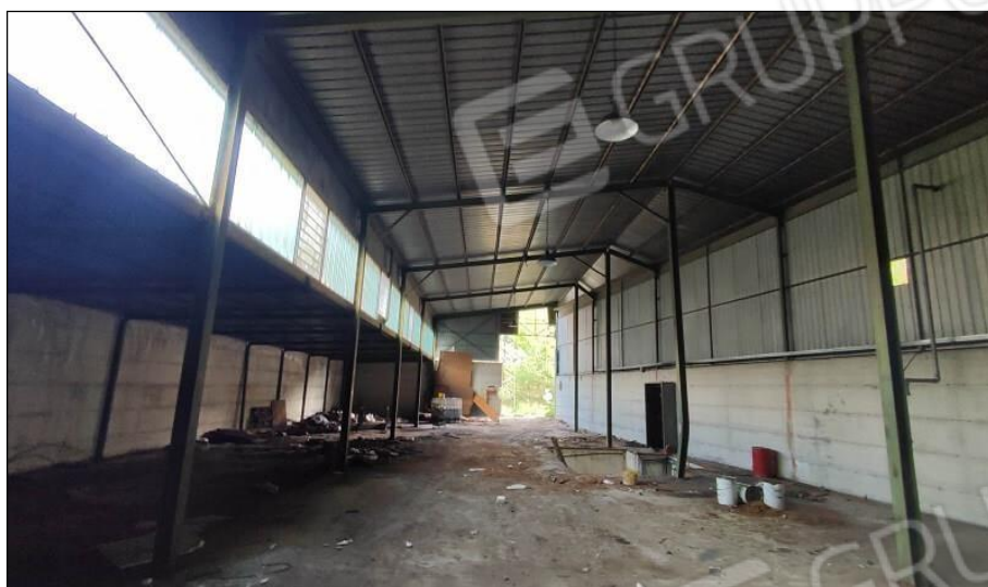
Vista interna parte principale dell'immobile F
