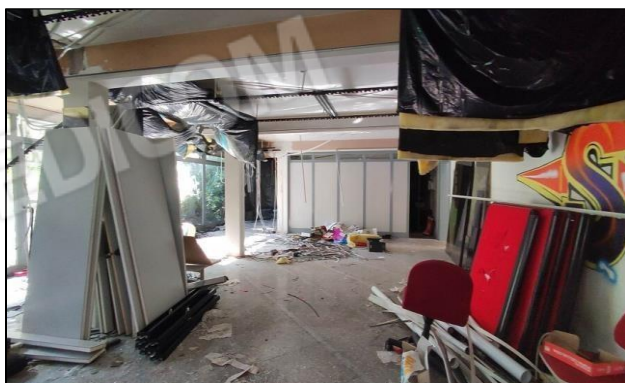
Vista interna degli uffici piano terra
