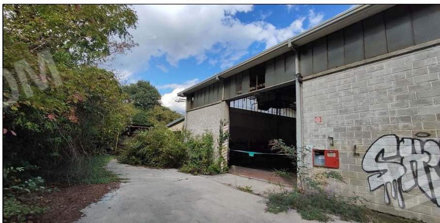
Lato ovest con ingresso al capannone
