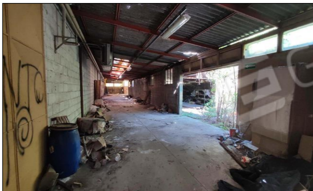
Vista immobile D – officina
