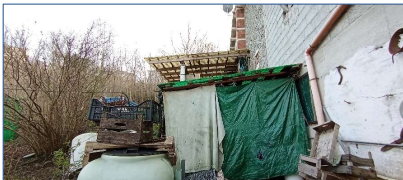
Baraccamenti lato est
