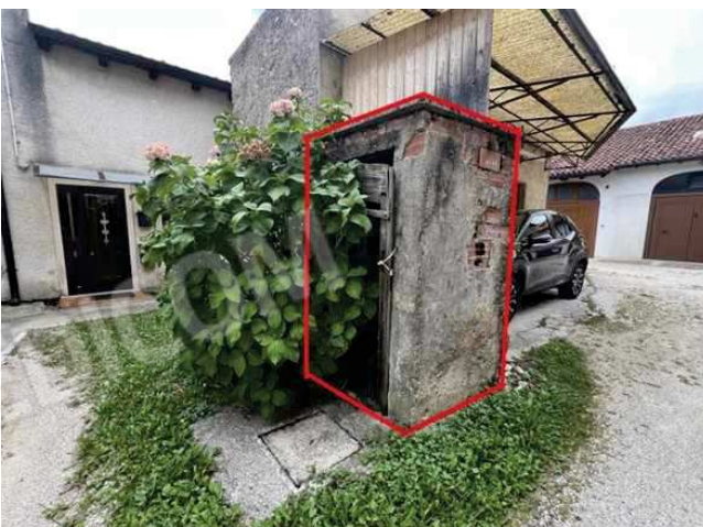
Vista del manufatto (wc) sulla corte esclusiva
