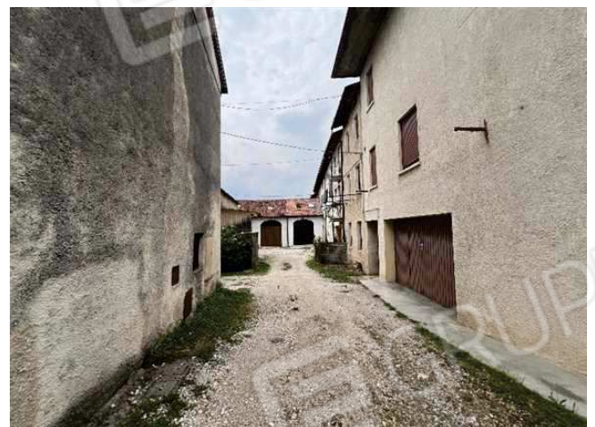
Vista dell'ingresso dalla corte comune sul retro
