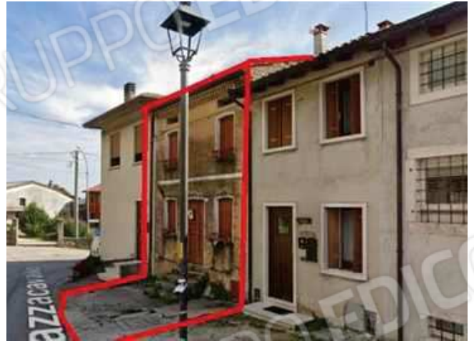
Vista della facciata dalla via Mazzacavallo
