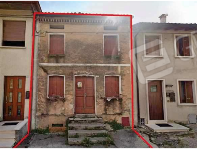
Vista della facciata dalla via Mazzacavallo
