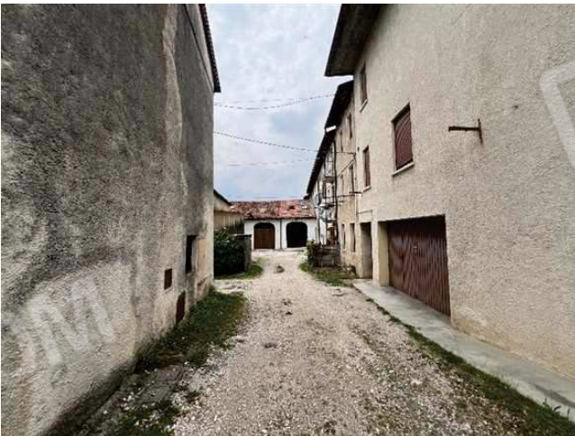
Vista dell'ingresso dalla corte comune
