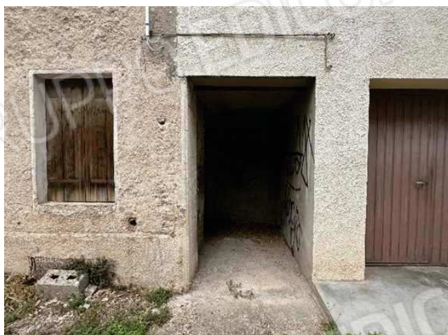
Vista dell'ingresso comune al ripostiglio del p.semint.
