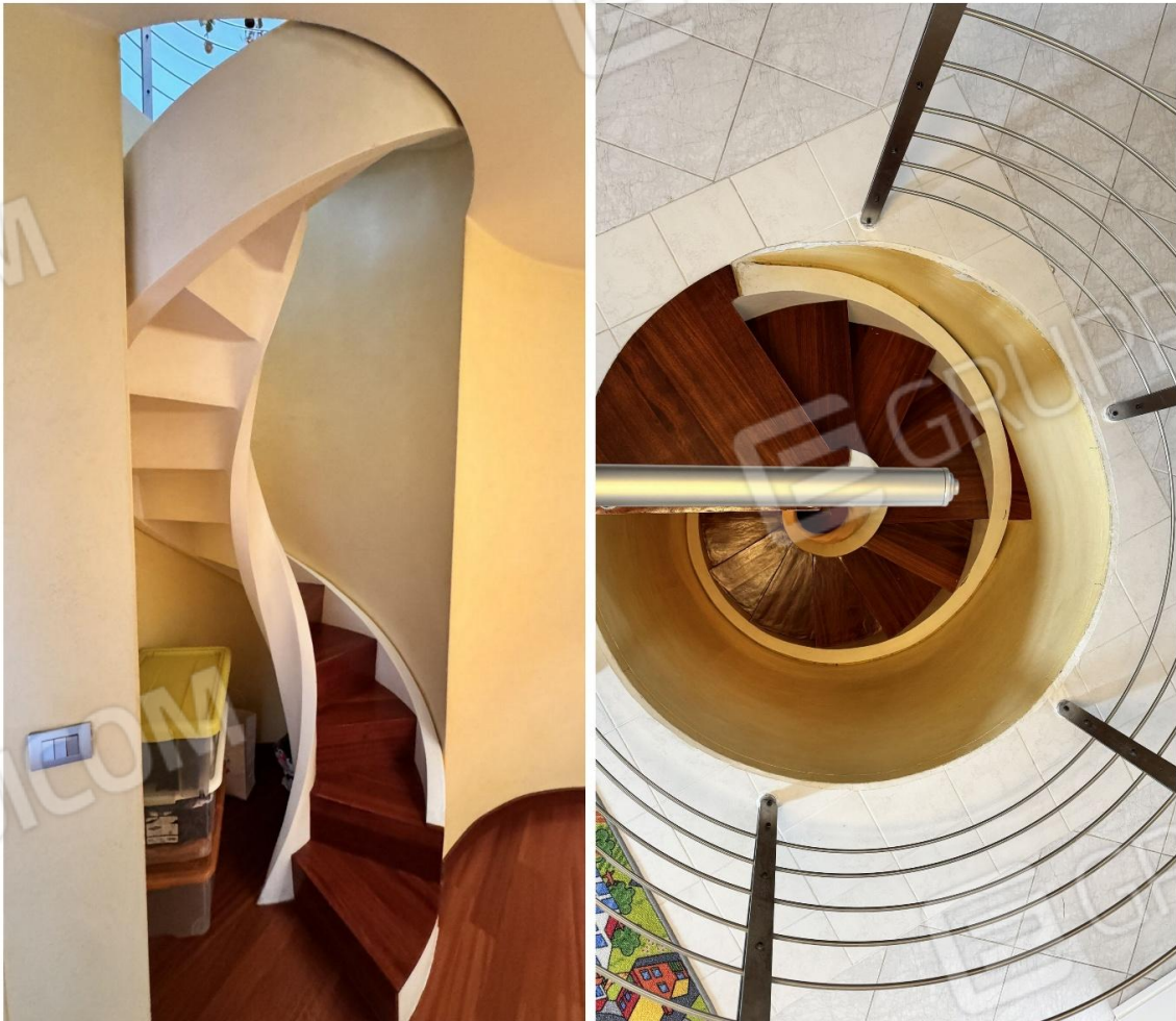
SOTTOTETTO – particolare scala a chiocciola
