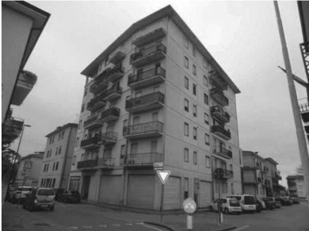
prospetto nord/est e nord/ovest con individuazione immobile oggetto di perizia
