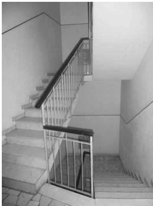
vano scale comune
