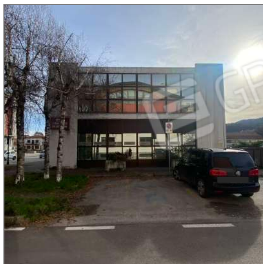
FOTO 5 - Vista da Via Trento - fronte Nord
