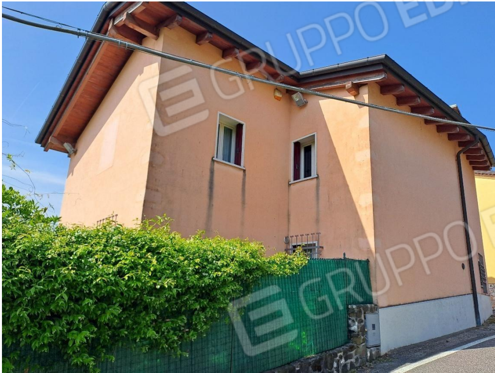
Vista da Nord-Est
