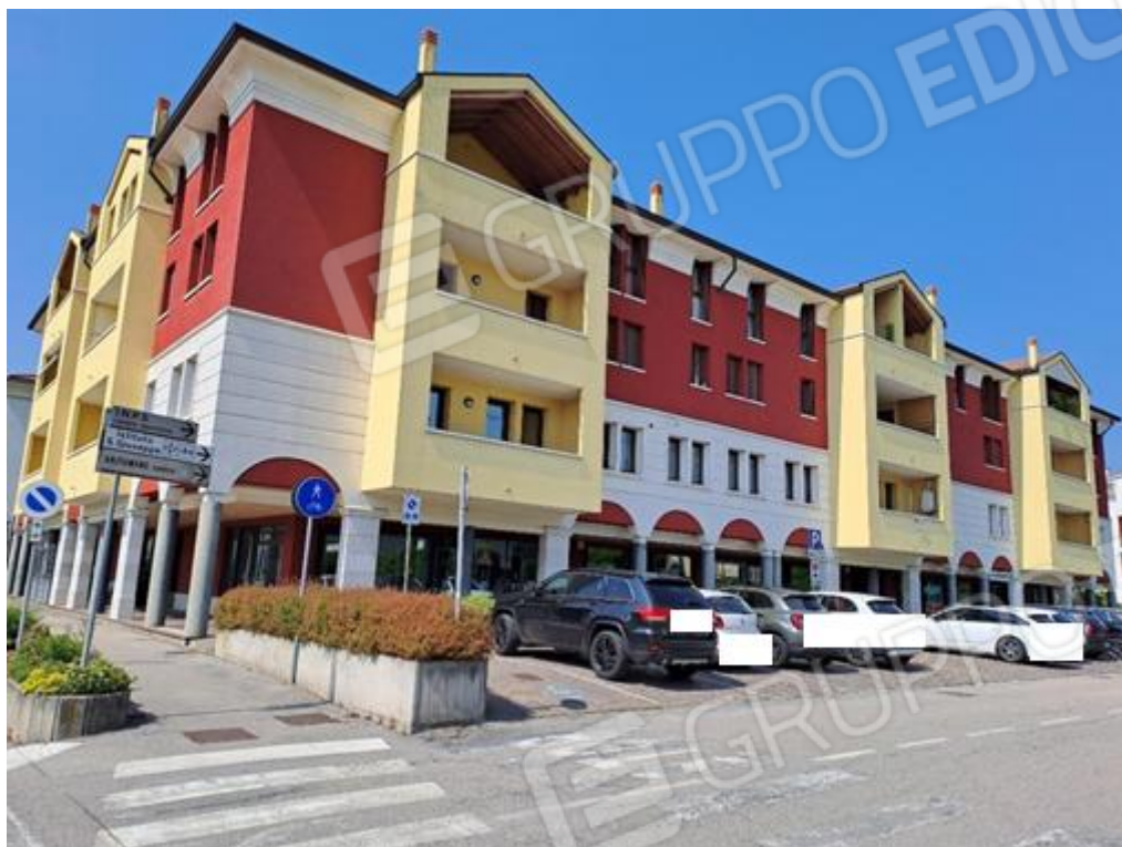
Vista generale da Nord-Est
