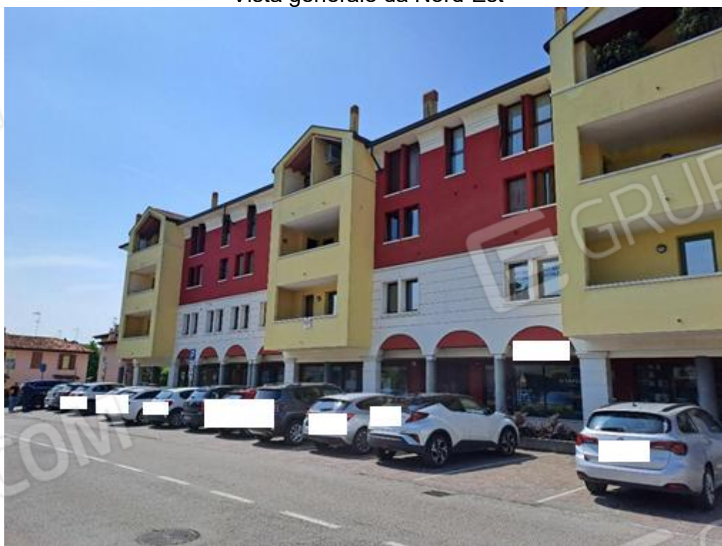
Vista generale da Nord-Ovest
