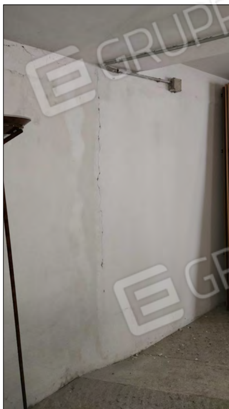
Particolare fessurazioni/umidità
