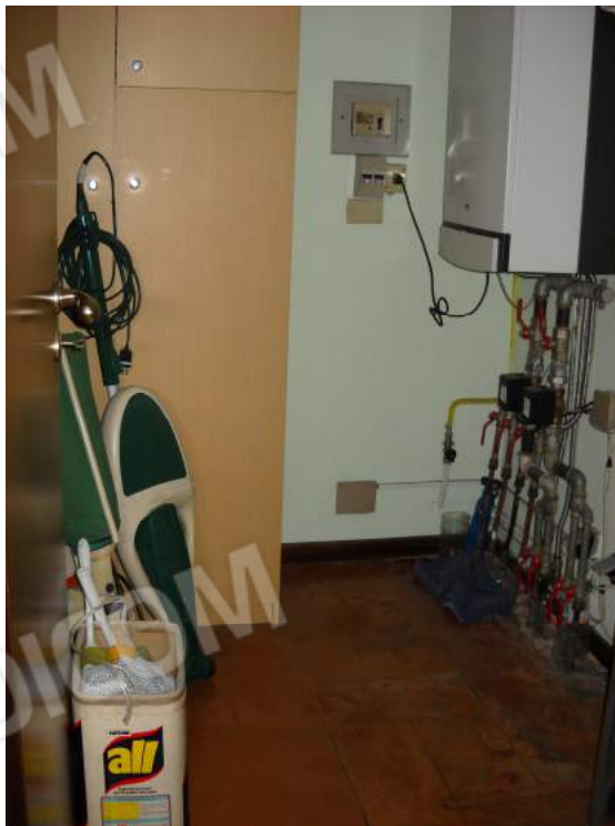
Locale ripostiglio e centrale termica
