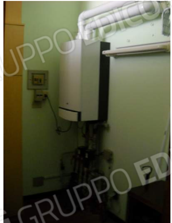
Locale ripostiglio e centrale termica
