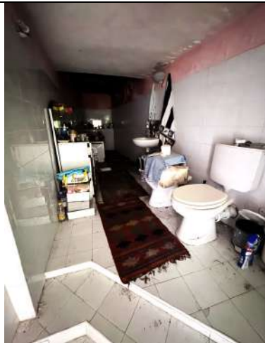
Foto 9 – bagno con accesso dalla camera da letto
