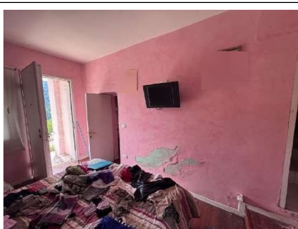
Foto 11 – camera matrimoniale piano terra
