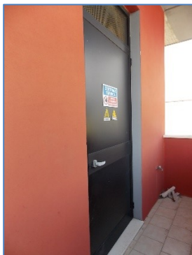
30. terrazza e accesso vano caldaia
