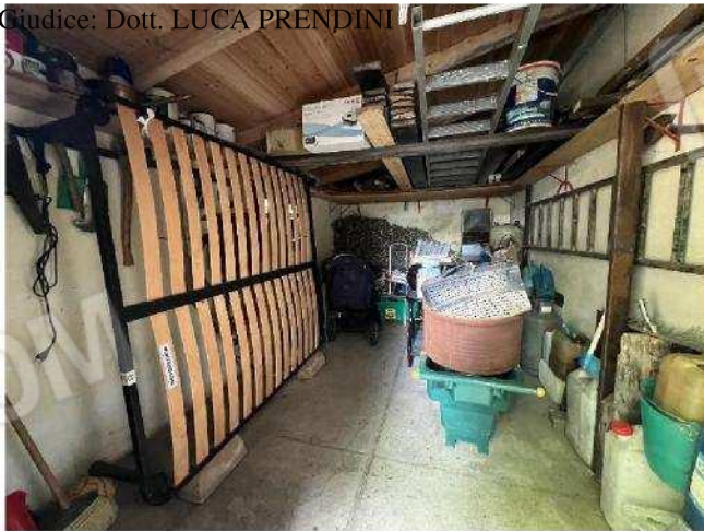
Vista dell'autorimessa abusiva
