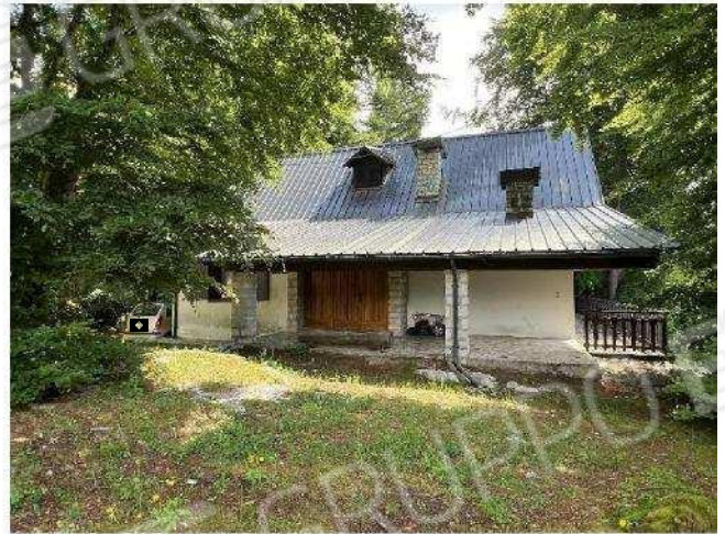
Vista dell'edificio da Sud Ovest
