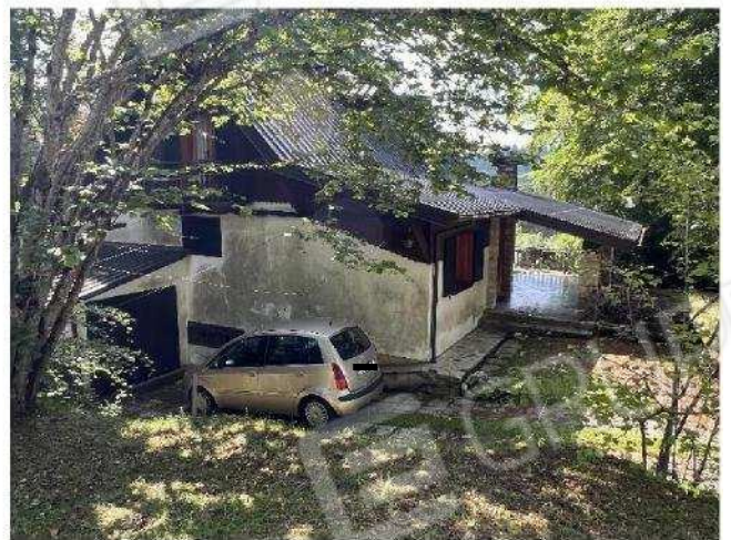
Vista dell'edificio da Nord Ovest
