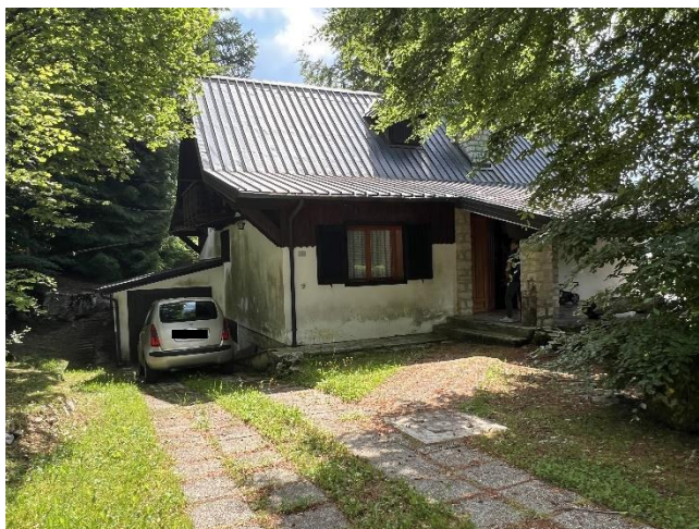
Vista dell'edificio da Nord Est
