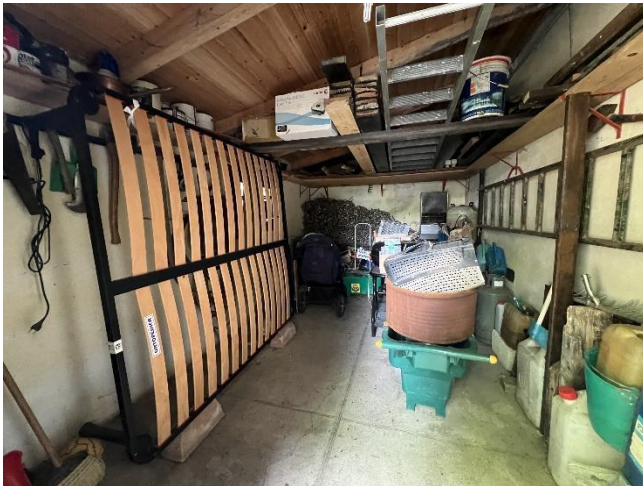
Vista dell'autorimessa abusiva
