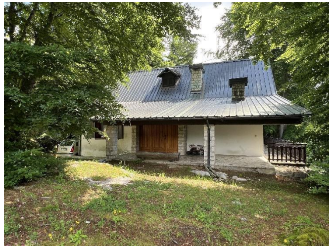
Vista dell'edificio da Sud Ovest
