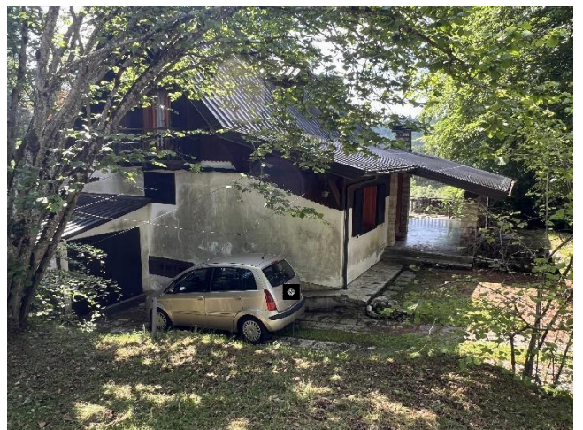
Vista dell'edificio da Nord Ovest
