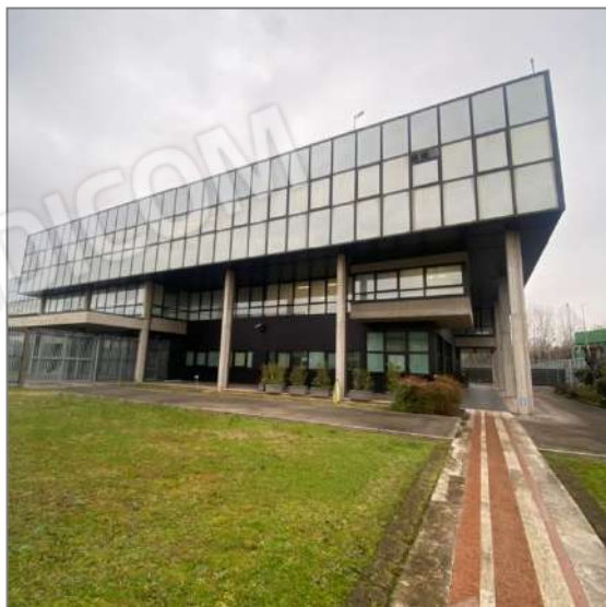
FOTO 5 - L'ingresso da Via Vecchia Ferriera
