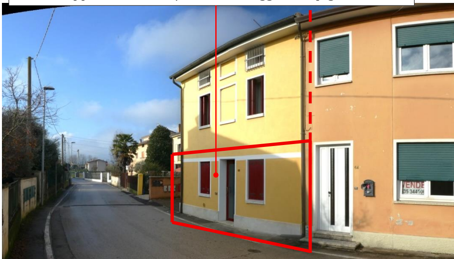
1. – Fabbricato mappale 133-137 – lato Sud fronte Via IV Novembre
