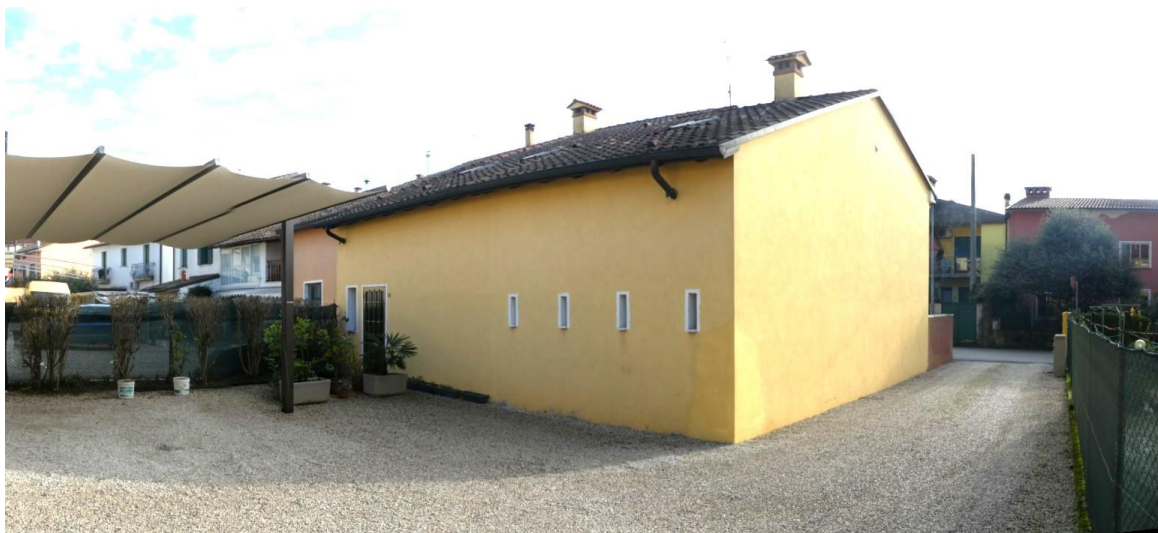
3. – Fabbricato mappale 133-137 – lato Nord/Ovest
