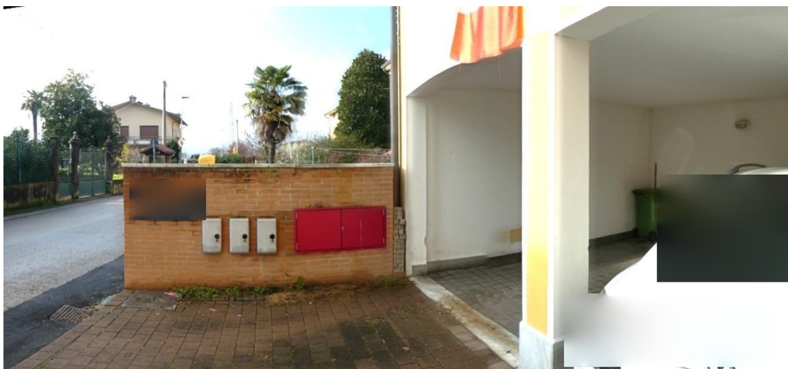
4. - Fabbricato mappale 133-137 – corte e portico comuni mapp. 133 sub. 5-6
