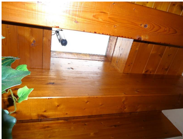
19. – Abitazione mappale 581 sub. 8: Lucernario Bagno al piano Primo
