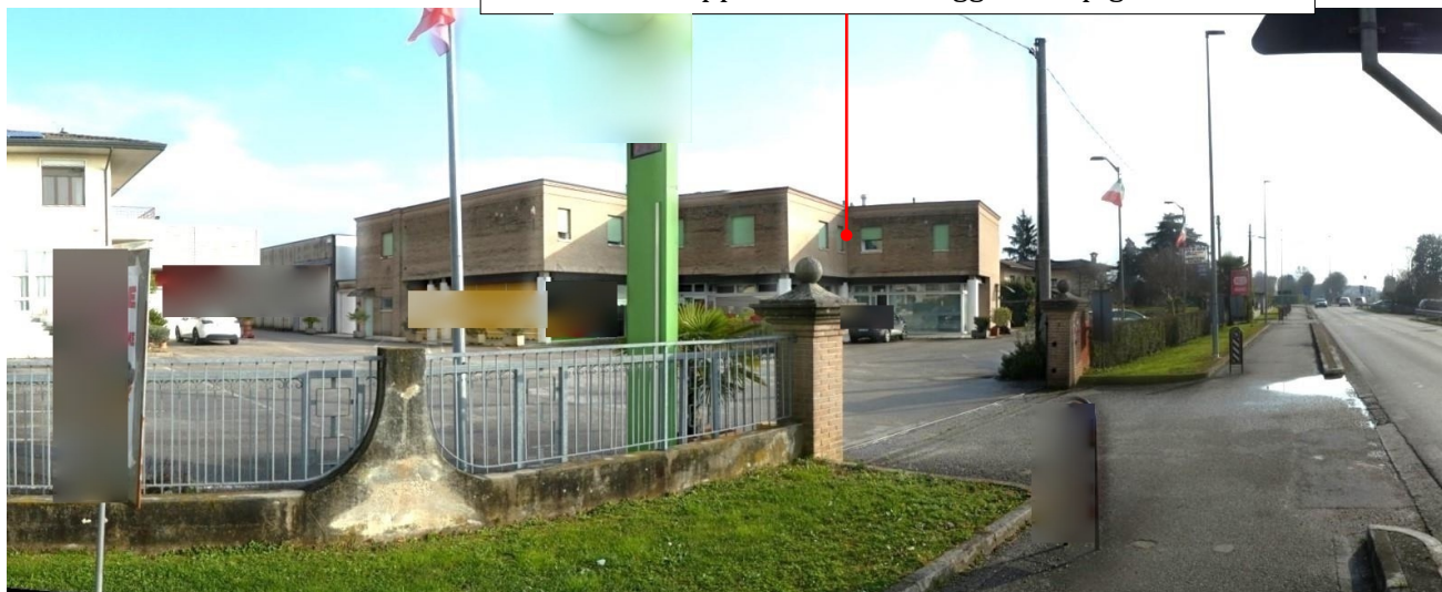
1. – Accesso al complesso mappale 581 (e altri) dalla strada Via Palazzina – lato Nord/Ovest
