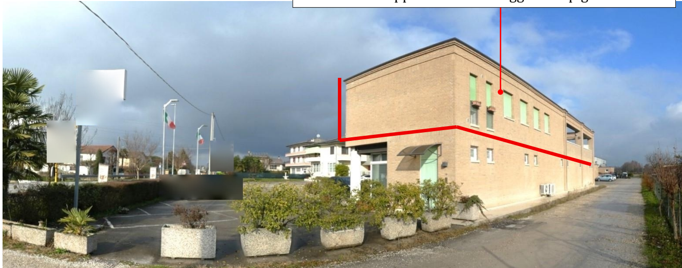
6. – Fabbricato mappale 581 – lato Sud/Ovest fronte strada privata
