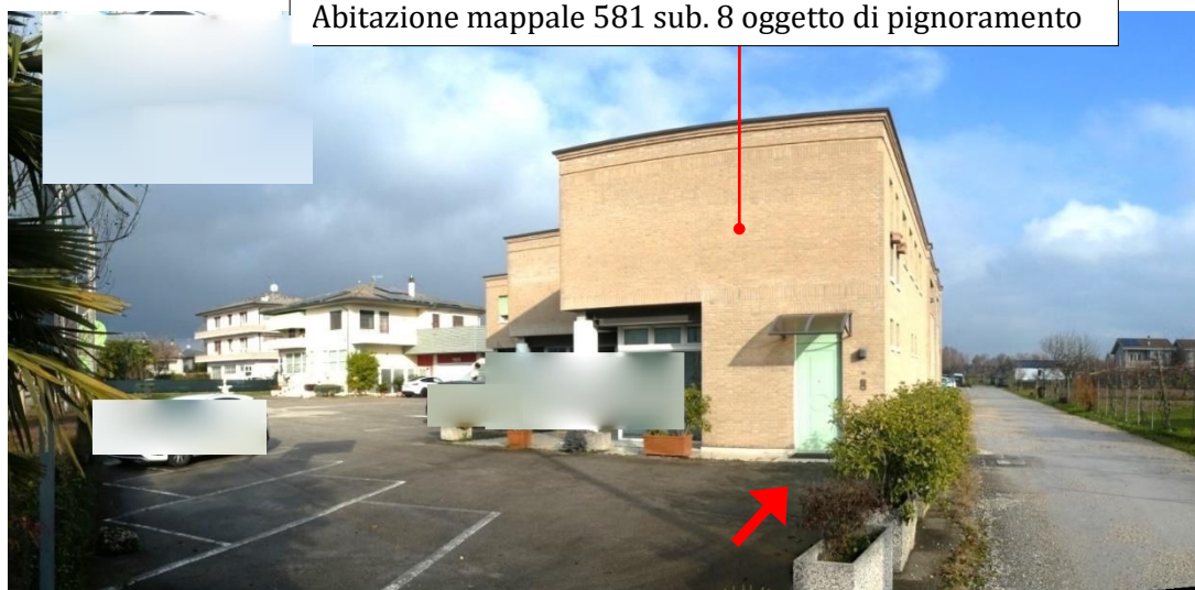
5. - Fabbricato mappale 581 – lato Ovest con accesso all’abitazione sub. 8 dal piano Terra
