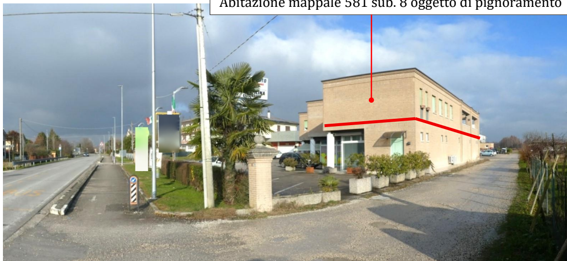
2. – Fabbricato mappale 581– lato Sud/Ovest fronte Via palazzina
