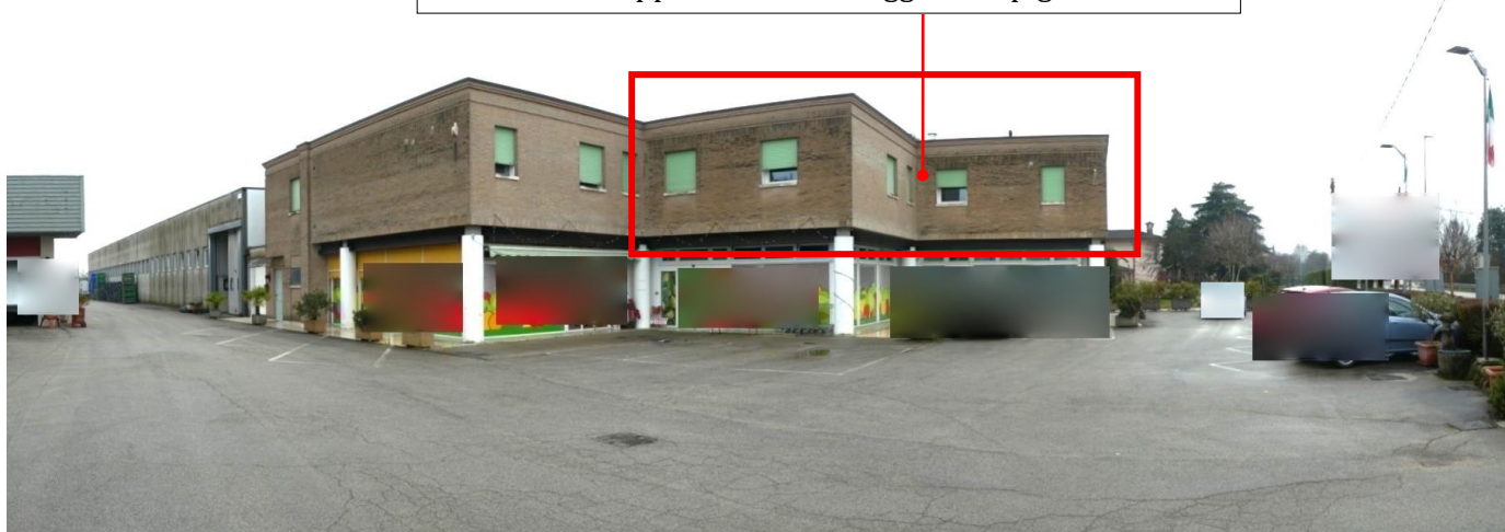
3. – Fabbricato mappale 581 – lato Nord/Ovest fronte corte comune
