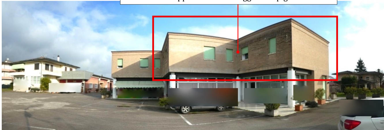
4. – Fabbricato mappale 581 – lato Nord/Ovest fronte corte comune
