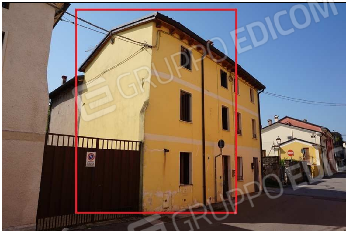
FOTO 1 – Vista da nord/ovest
