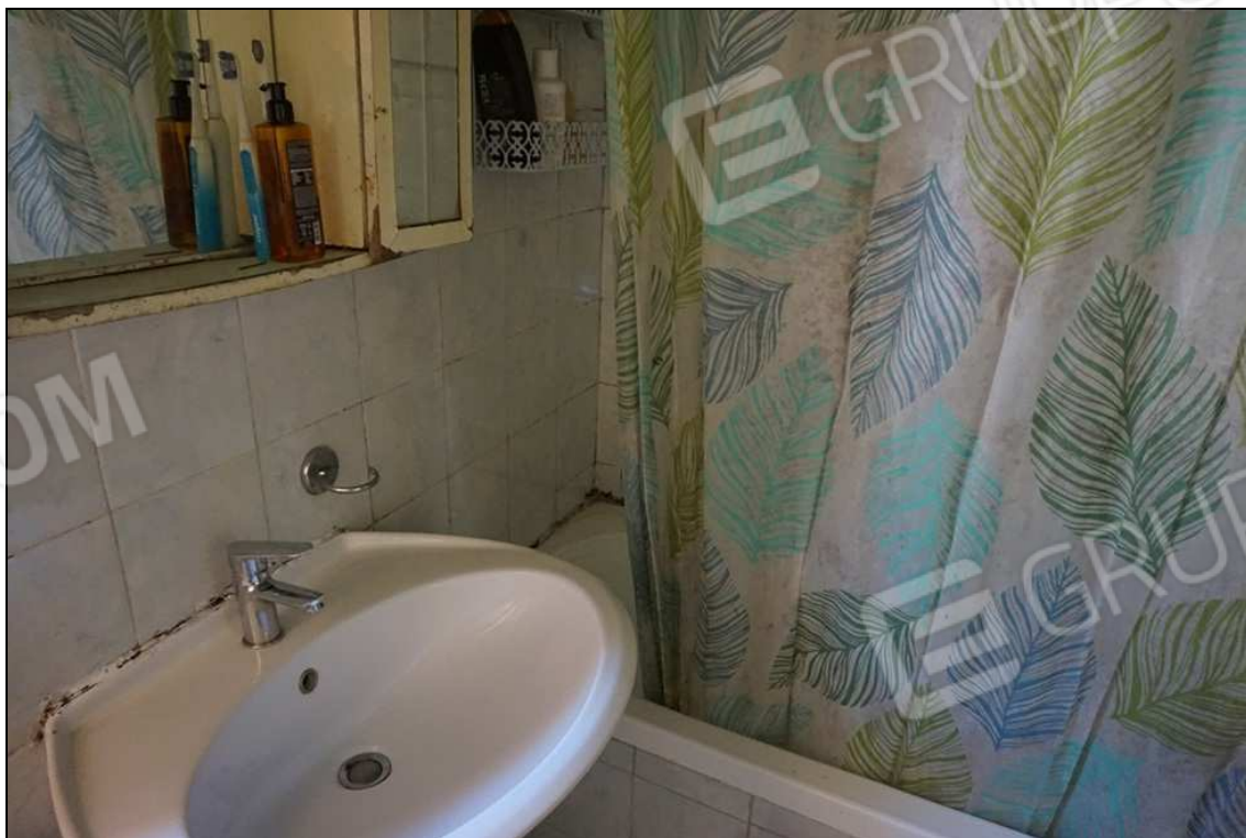
FOTO 18 – Piano primo – Bagno
