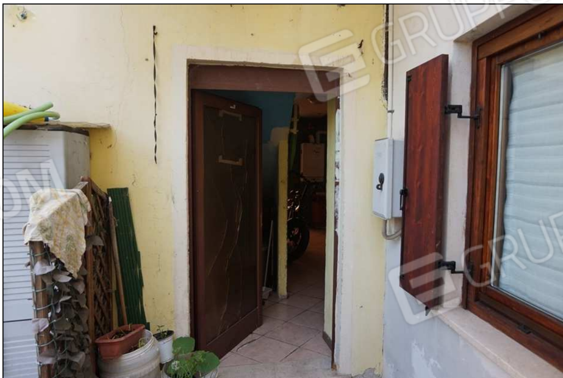
FOTO 8 – Particolare ingresso da corte comune ad est
