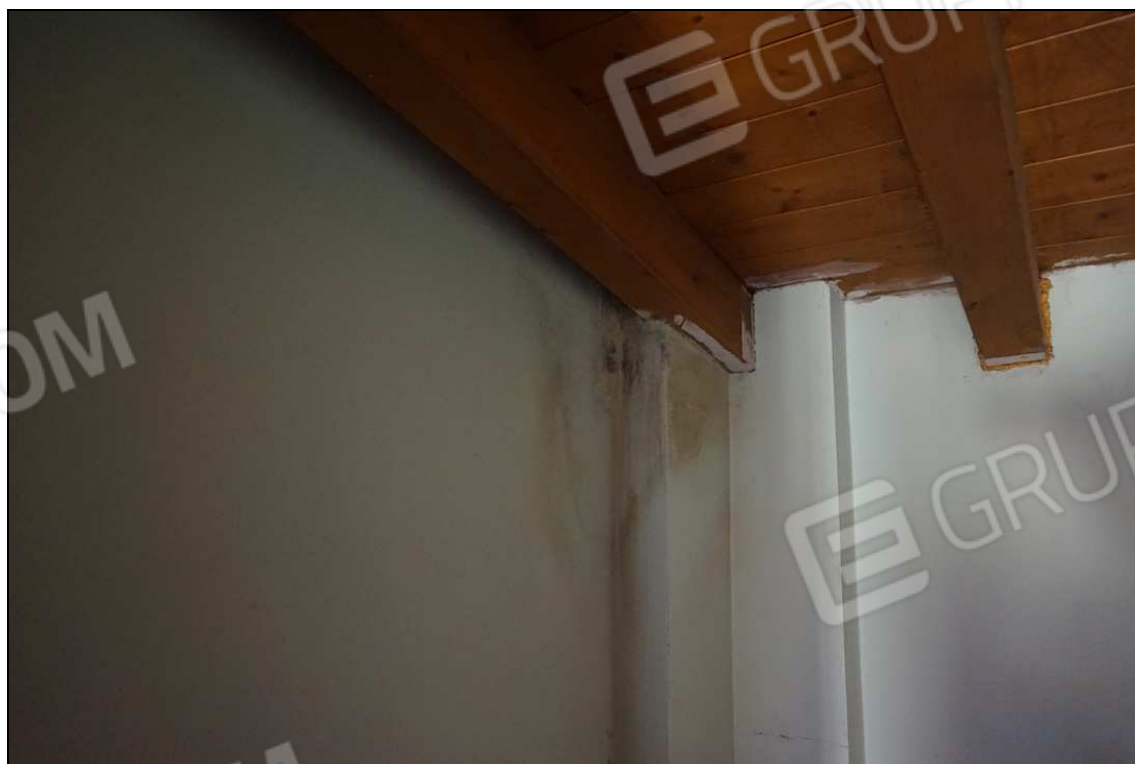
FOTO 28 – Piano secondo – Angolo nord/est soffitta a nord
