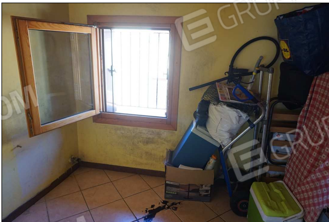
FOTO 24 – Piano secondo – Soffitta a sud
