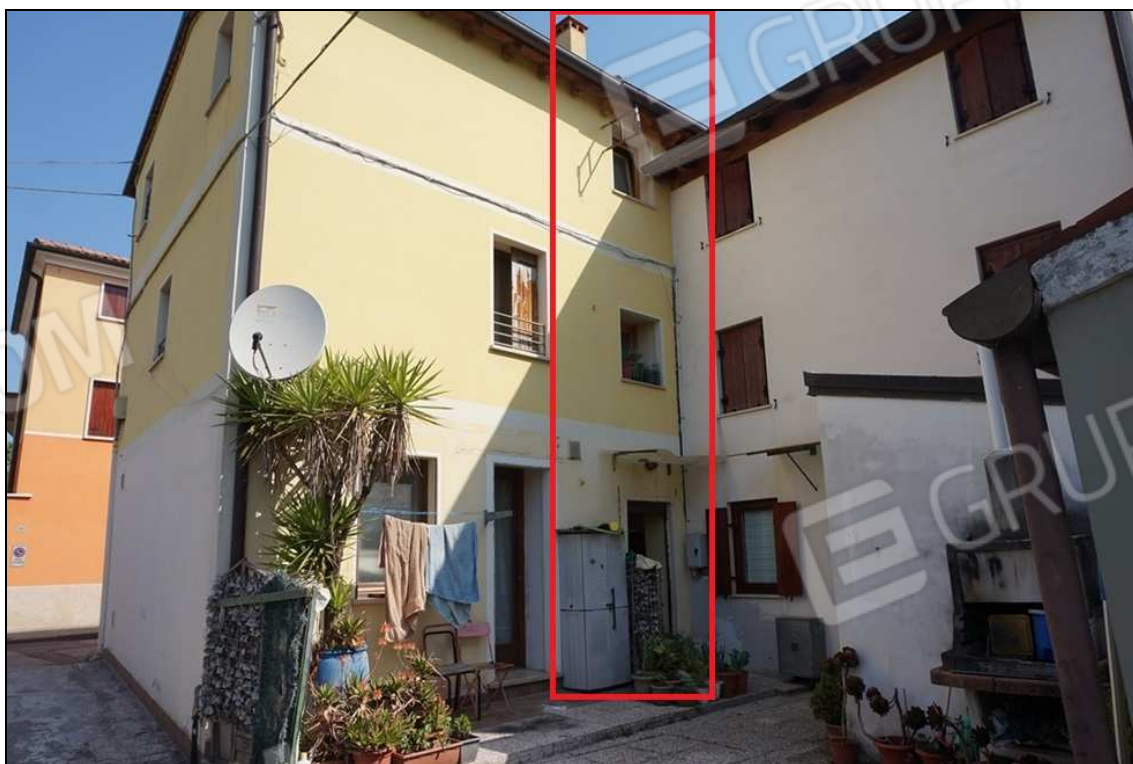
FOTO 6 – Vista da sud/est
