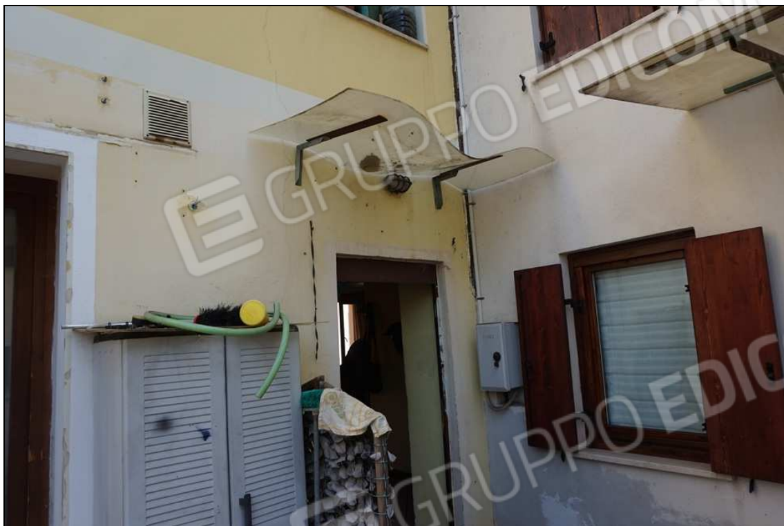
FOTO 7 – Particolare ingresso da corte comune ad est
