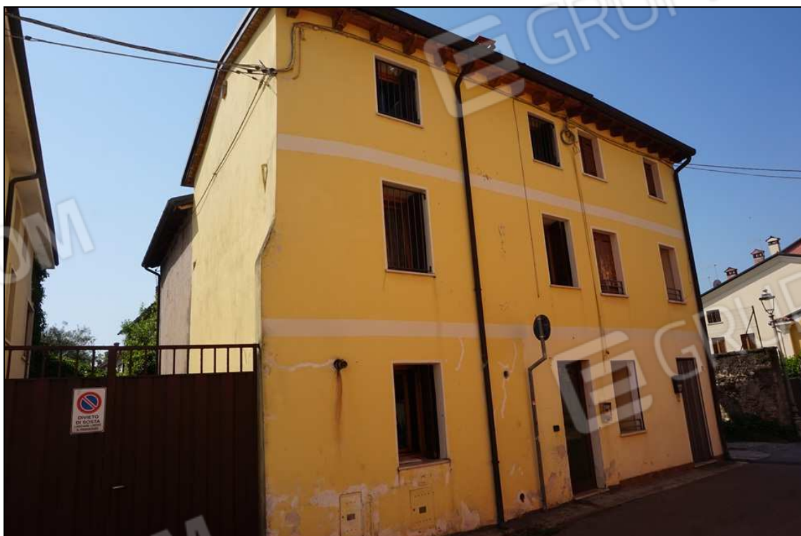
FOTO 2 – Vista da nord/ovest
