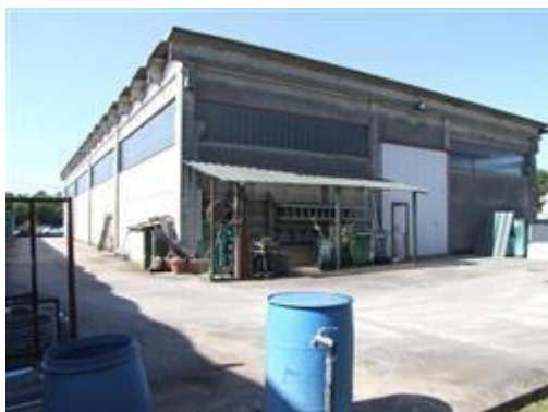
Tettoia con struttura precaria metallica leggera
