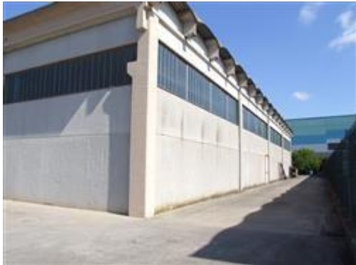
Veduta da Sud-Est
