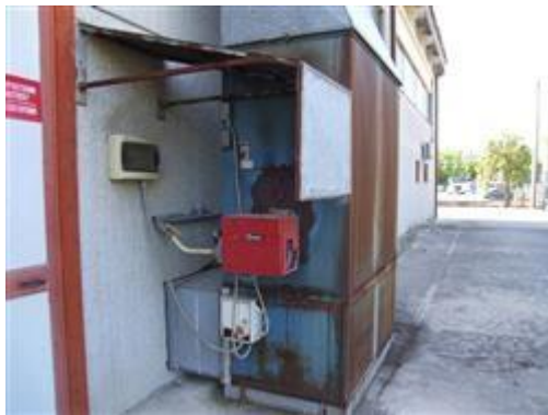
Posizionamento impianto di climatizzazione invernale
