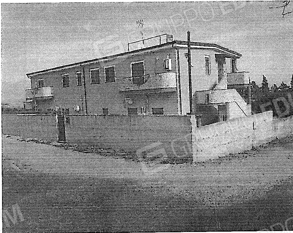
VISTA DALL'ESTERNO DEI LATI: SUD/OVEST E SUD/EST
