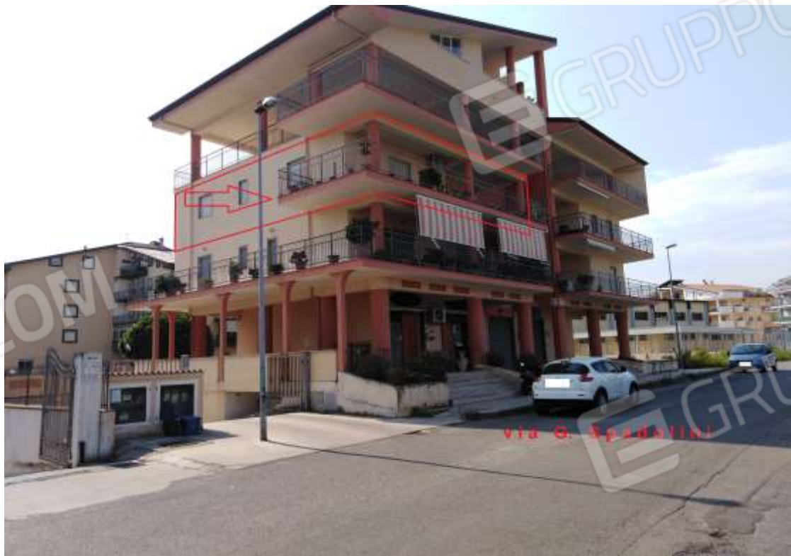
Foto n° 2 – Unità immobiliare pignorata sub 6: vista prospetto nord est e nord ovest.
