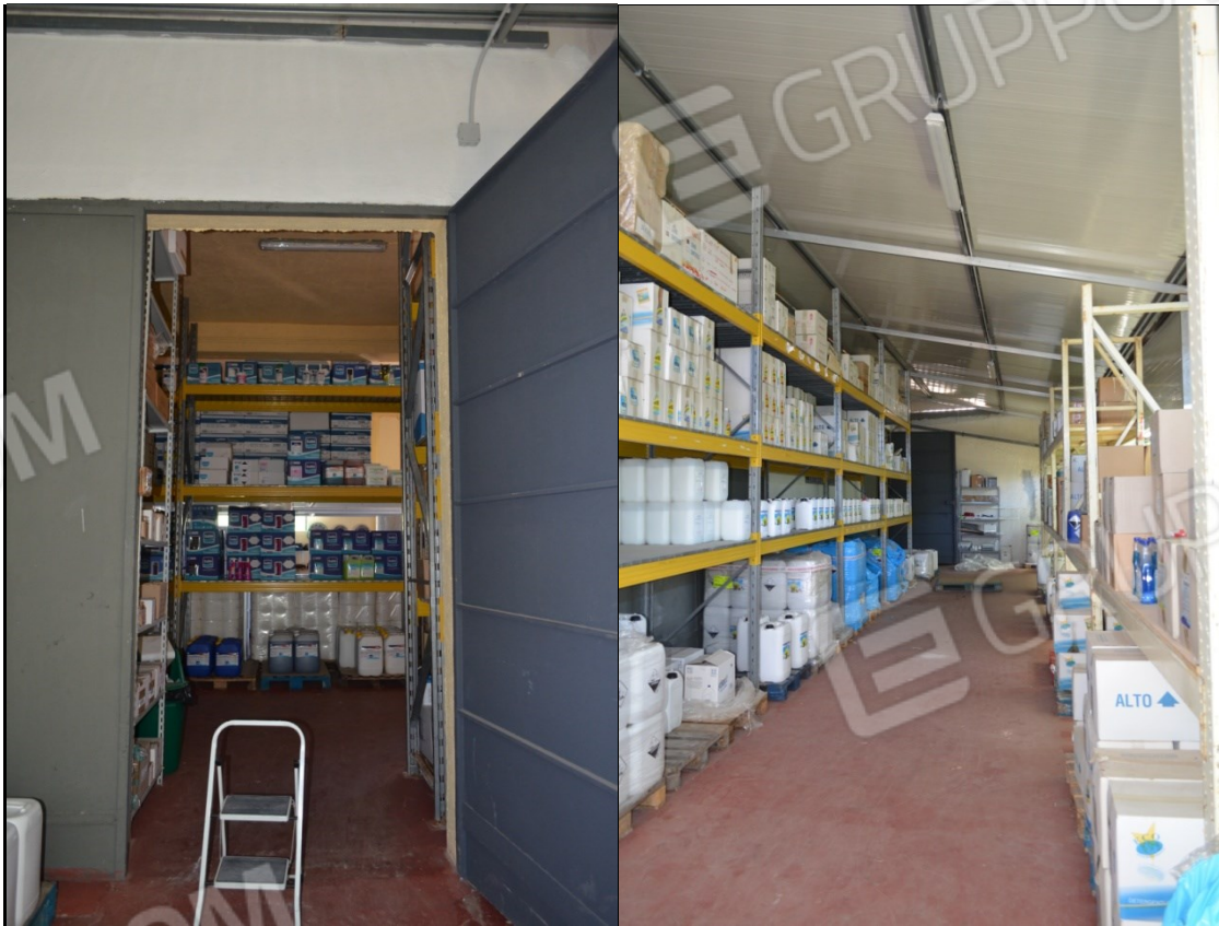
Foto n.21, 22 e 23. Tettoia abusiva.
