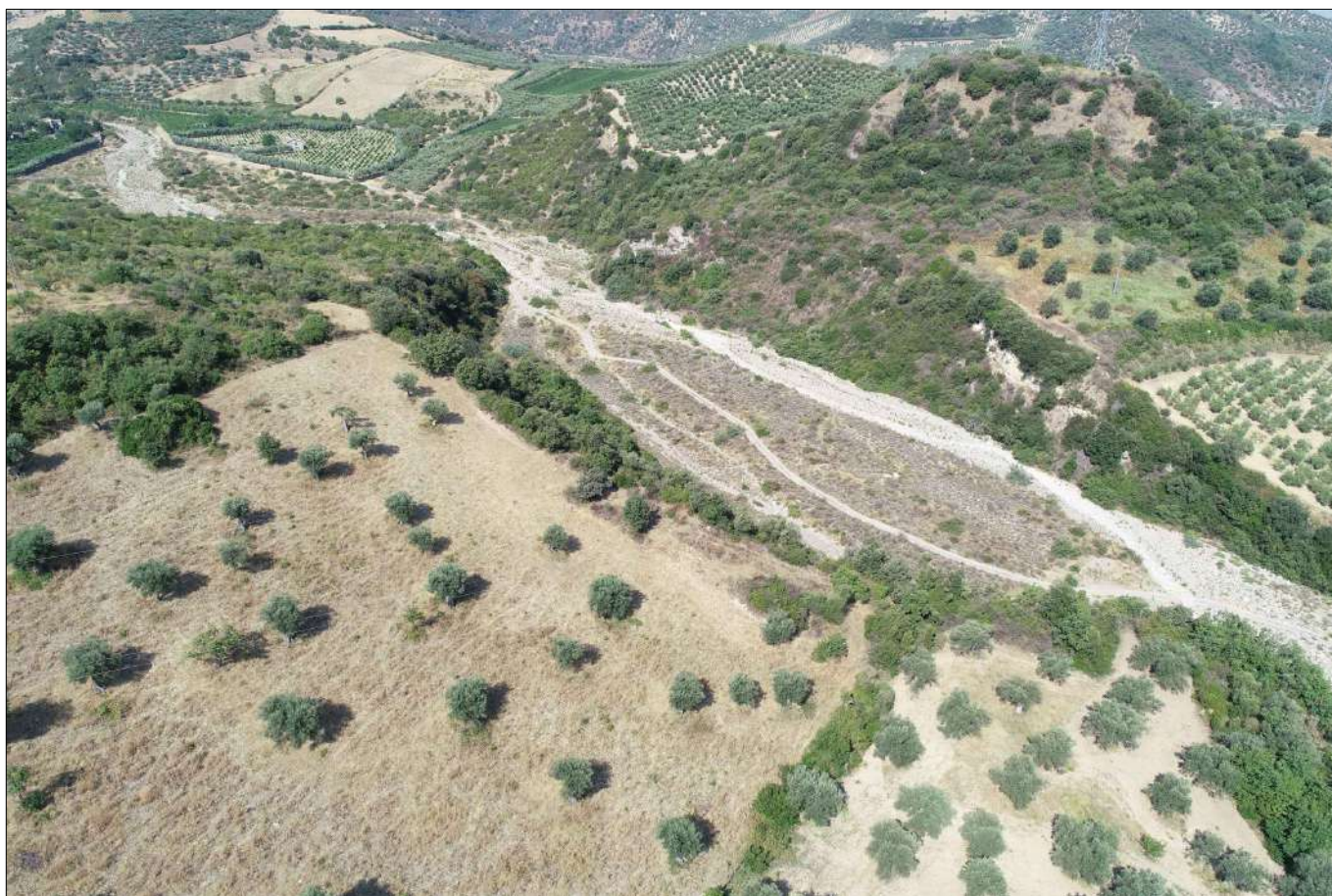
Veduta area individuata con la particella 81 confinante con l'alveo del torrente Otturi
