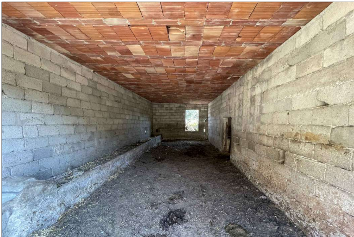
Interno campata ovest del fabbricato rurale individuato con la particella 502 sub 1
