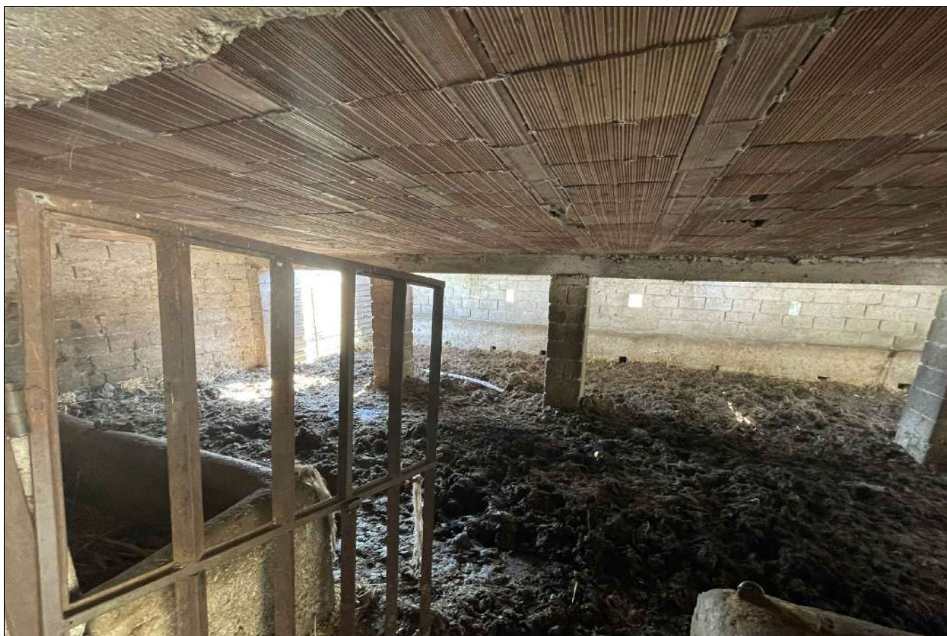
Interno campata est del fabbricato rurale individuato con la particella 502 sub 1
