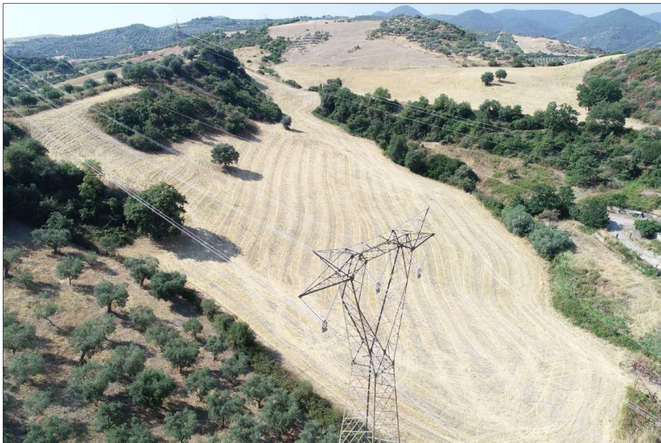
Veduta area individuata con le particelle 500 e 506
