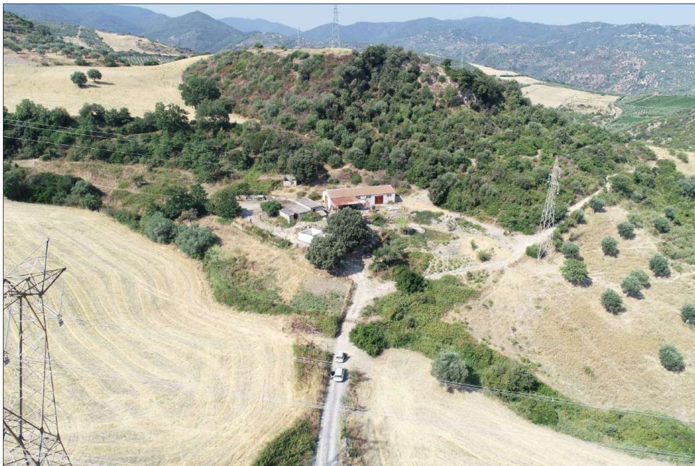
Fabbricati rurali individuati con le particelle 502 sub 1 e 504 sub 1
