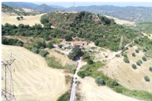
Manufatti realizzati presso l'area identificata con il mappale 503
