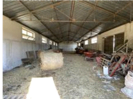
Veduta dell'interno del capannone
