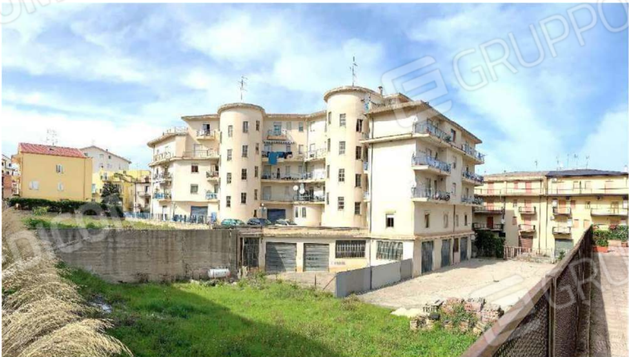
Figura 4 – Area di pertinenza (foto da via Boccaccio)
