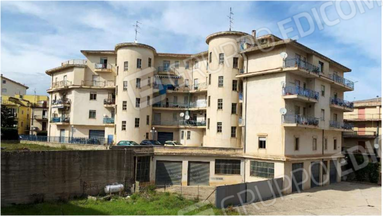
Figura 5 – Area di pertinenza (foto da via Boccaccio)
