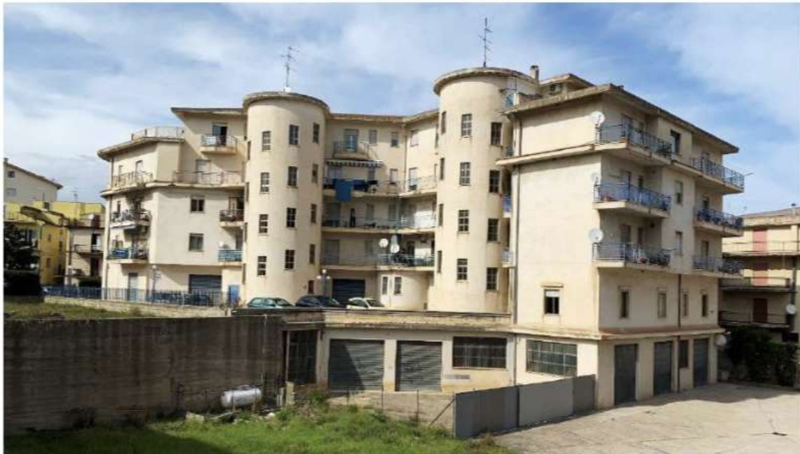
Figura 5 – Area di pertinenza (foto da via Boccaccio)
