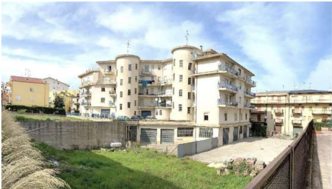
Figura 4 – Area di pertinenza (foto da via Boccaccio)
