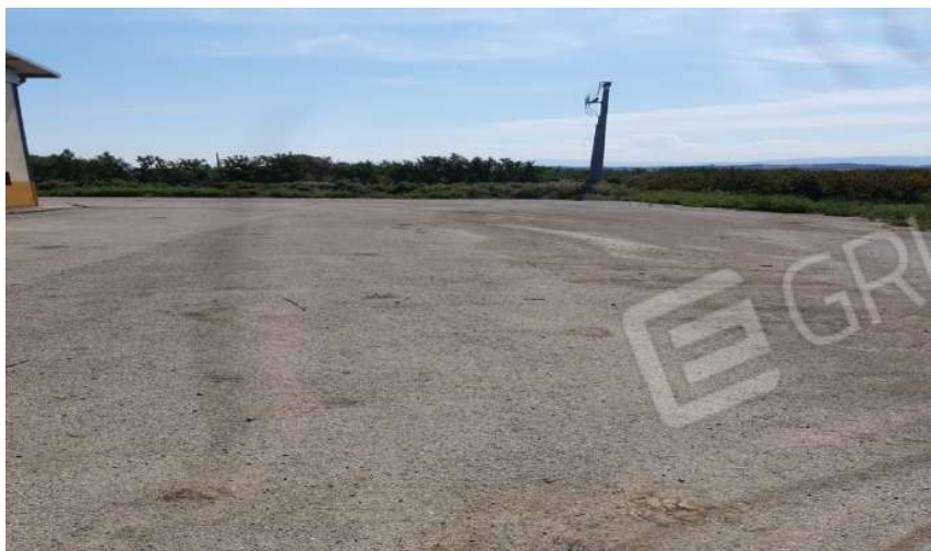
FOTO N.12: particolare area esterna capannone
