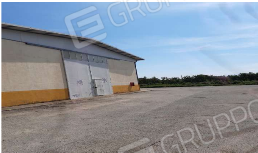
FOTO N.11: capannone lato ovest
