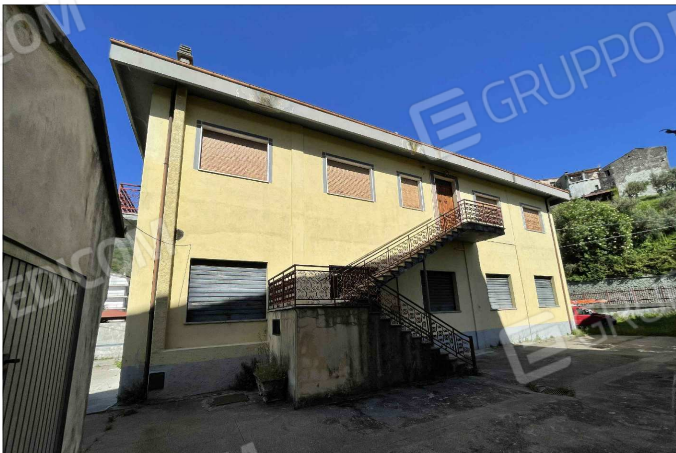
Scala di accesso all'abitazione oggetto di interesse al piano primo
