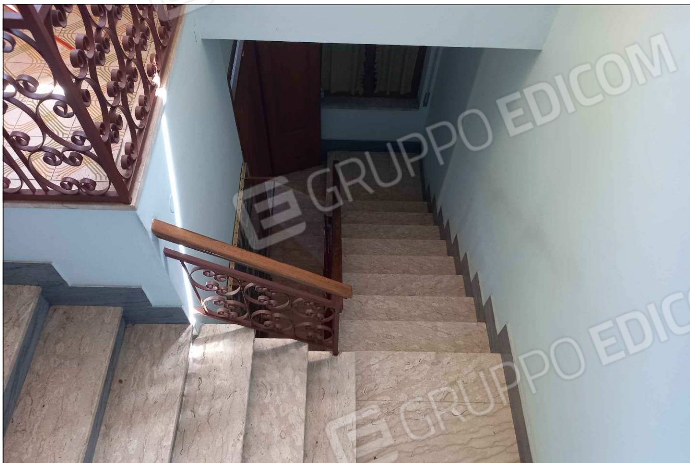
Scala interna di collegamento al piano sottotetto
