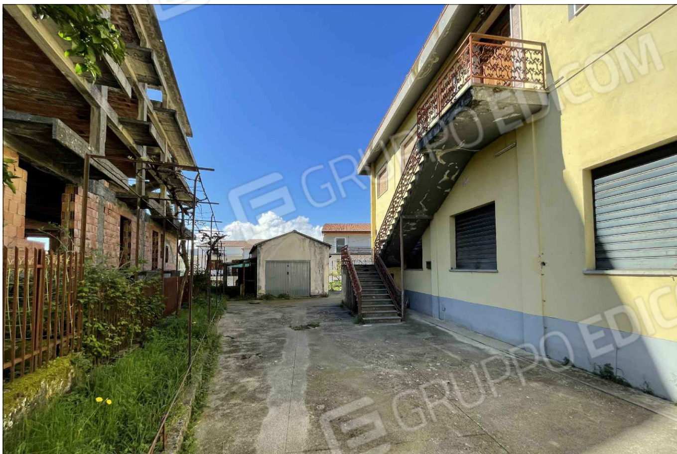
Corte di pertinenza - manufatto ricadente sulla particella 336 ed in minima parte sulla particella 337
