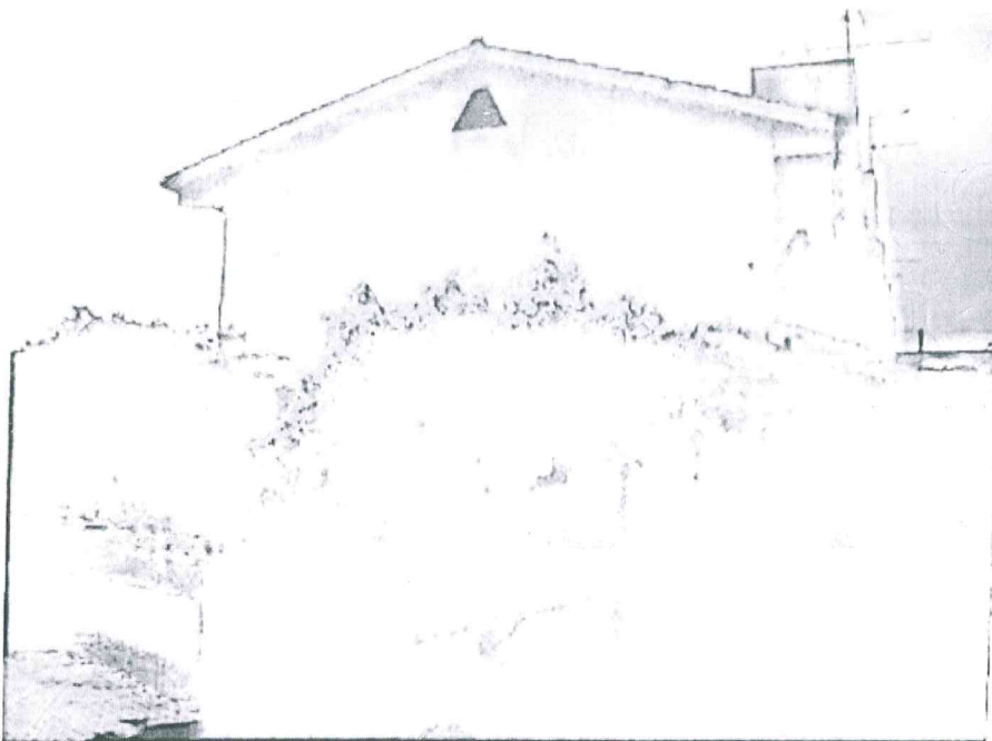
Foto 2 Parte laterale fabbricato – lato sud
