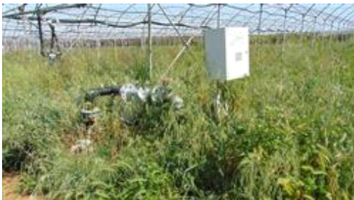
Vista particolare Pozzo di approvvigionamento idrico ubicato all'interno della p.lla 176
