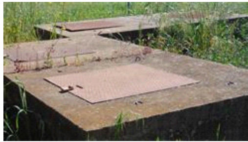
Particolare servitu-pozzetti acquedotto d'irrigazione
