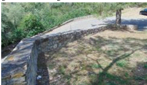
Vista 2_Area sistemata adiacente Strada comunale Madonna della Nova_ricadente sulla particella n. 111
