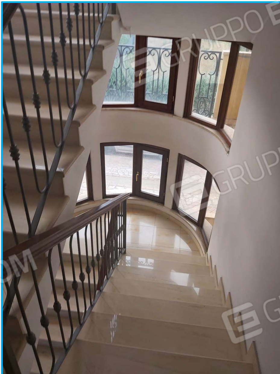
Corpo scale, vista dal piano primo.
