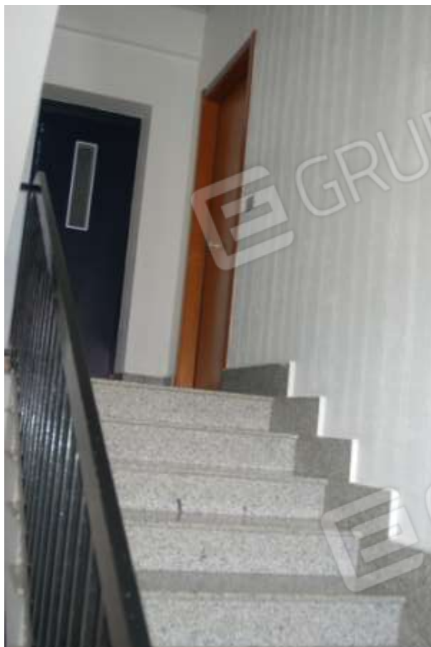
corpo scala condominiale
