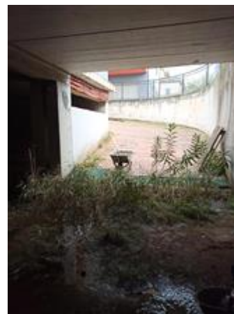
Rampa di accesso B all'interrato
