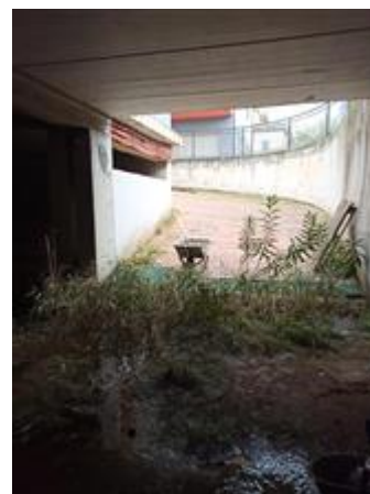
Rampa di accesso B all'interrato
