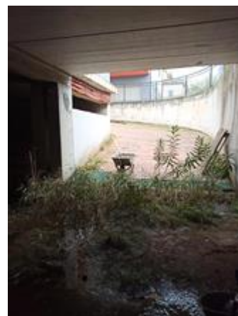
rampa di accesso B all'interrato
