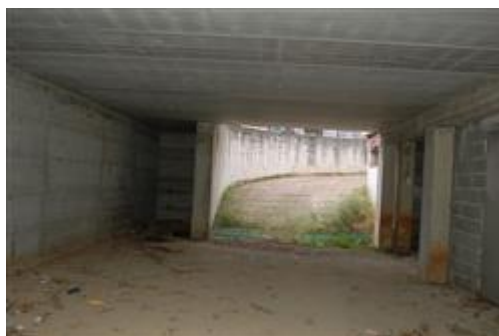
Rampa di accesso A all'interrato
