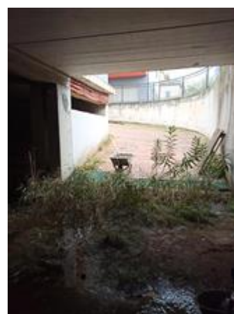
Rampa di accesso B all'interrato
