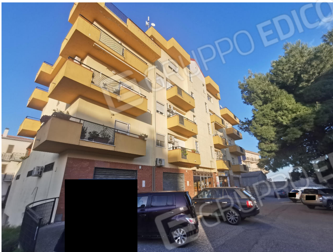
Foto 23: Edificio in comune di Corigliano Rossano località Cantinella - Fg. 32 p.la 1594.
