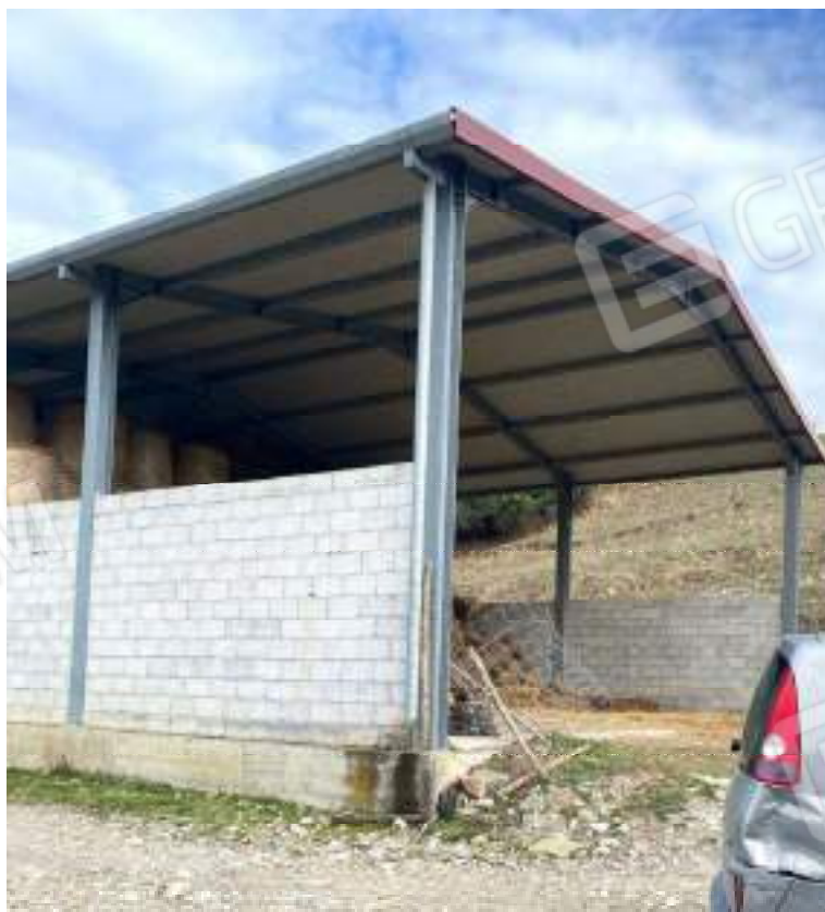
MAGAZZINO PROSPETTO SUD
