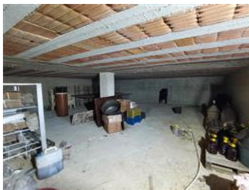
Foto 1 - Piano seminterrato ubicato nel corpo fabbricato del locale mensa (interni)
