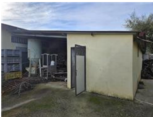
Foto 4 - Tettoia e locale deposito 1 sul lato Nord-Ovest del Capannone
