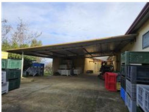
Foto 3 - Tettoia sul lato Nord-Ovest del Capannone
