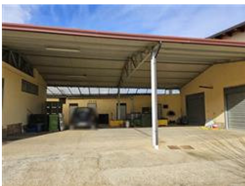
Foto 1 - Tettoia sul lato Nord-Est del capannone e facciata anteriore del locale deposito 2 (piano terra)
