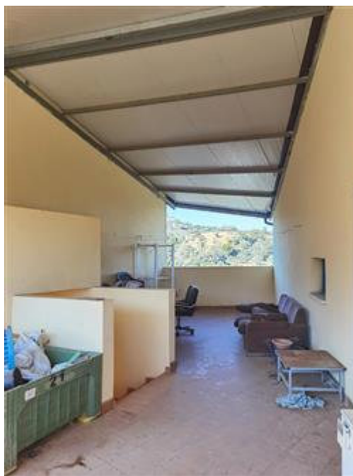
Foto 1 - Tettoia a copertura del pianerottolo/terrazzo
