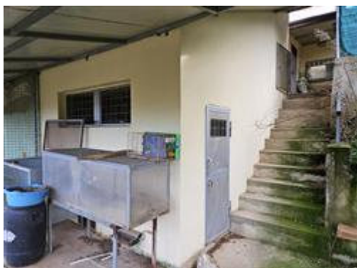
Foto 1 - Fabbricato denominato "Fabbricato T1" - Piano seminterrato (esterni)
