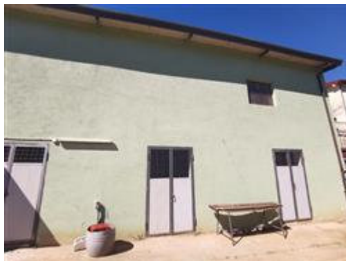
Foto 1 - Fabbricato adibito a conigliera e fienile
