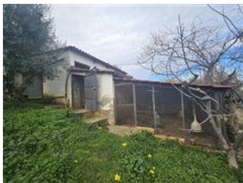
Foto 1 - Fabbricato ad uso deposito con adiacente pollaio
