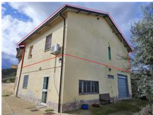
Foto 1 - Esterni (Appartamento A)
