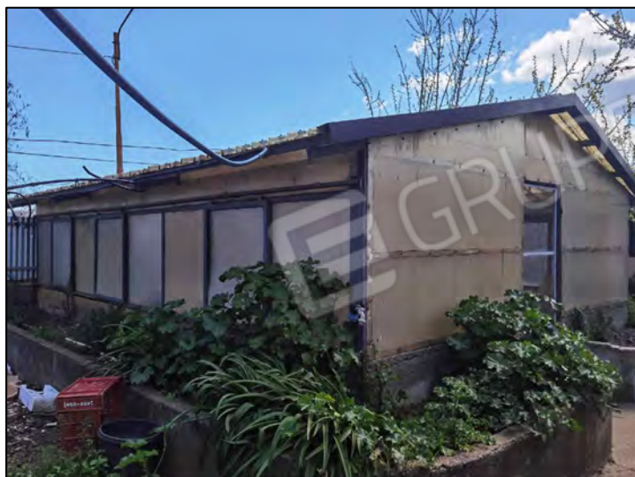
FOTO 288 - Lotto 5 - Fabbricato con struttura portante metallica
