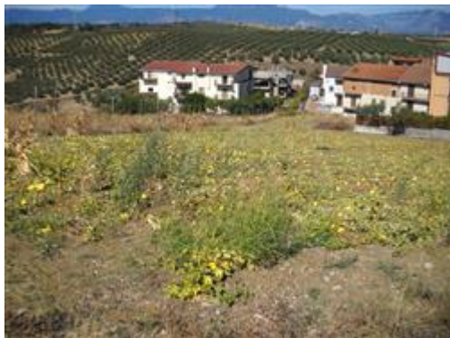
Vista dal lato sud
