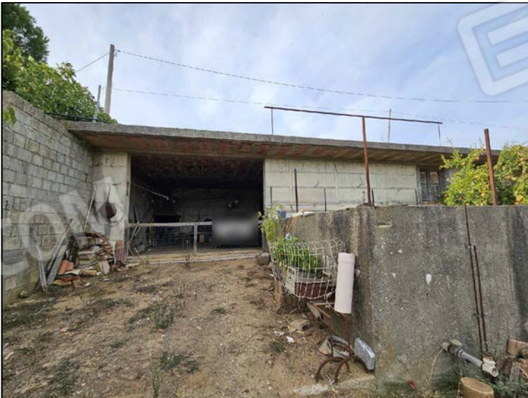
FOTO 43 - Lotto 3 - Corpo A - Esterni
