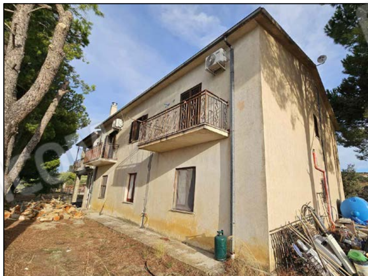
FOTO 3 - Esterni (Lotto 1 al piano terra e Lotto 2 al piano 1°)
