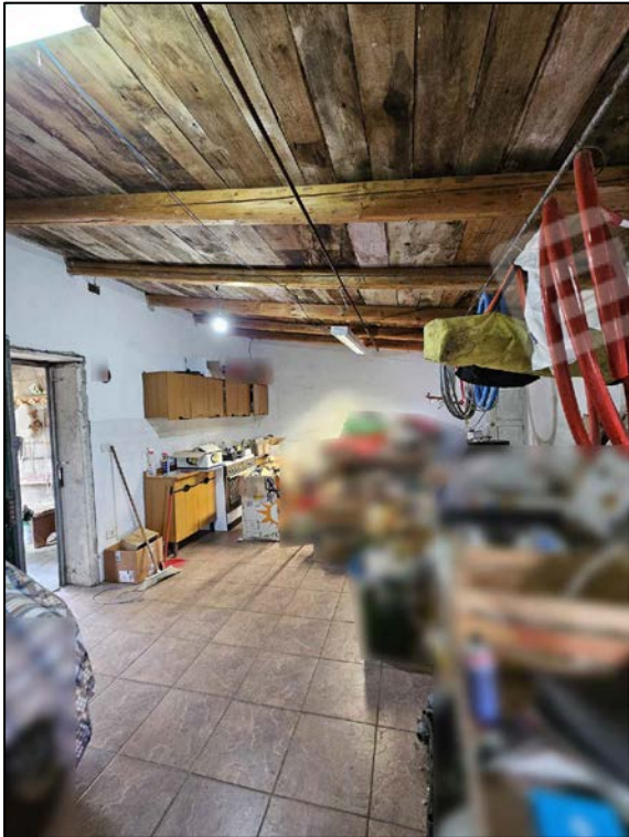
FOTO 52 - Lotto 3 - Corpo B - Interni Piano Terra Sub. 2
