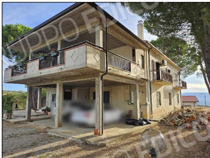
FOTO 2 - Esterni (Lotto 1 al piano terra e Lotto 2 al piano 1°)
