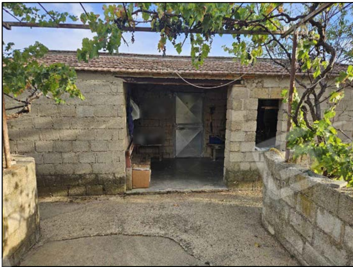
FOTO 46 - Lotto 3 - Corpo B - Esterni (ingresso al piano terra)
