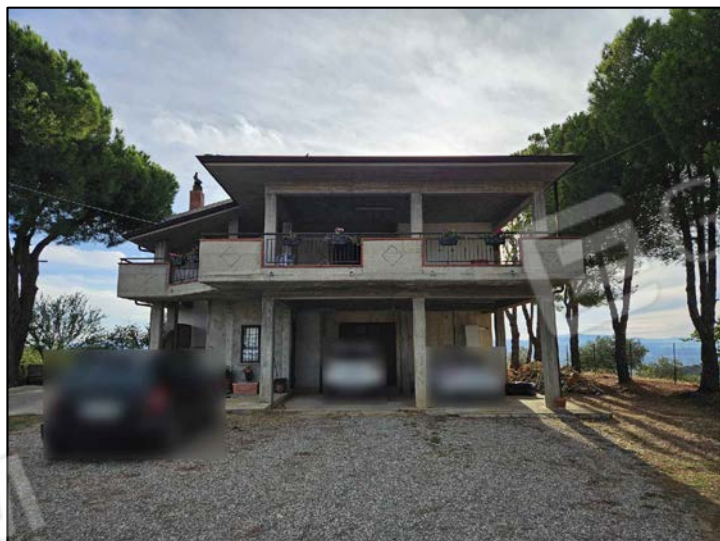
FOTO 1 - Esterni (Lotto 1 al piano terra e Lotto 2 al piano 1°)
