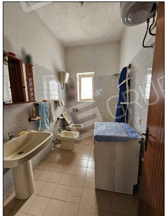
FOTO 18 - Lotto 1 - Corpo A - Interni (Bagno)
