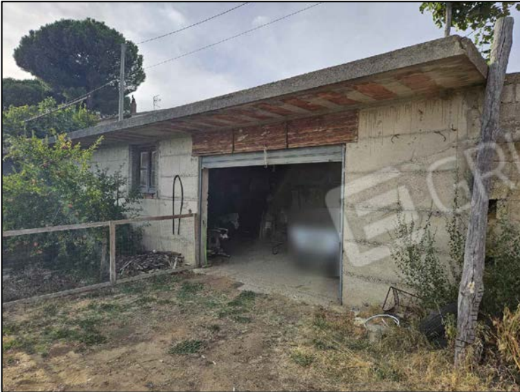
FOTO 41 - Lotto 3 - Corpo A - Esterni
