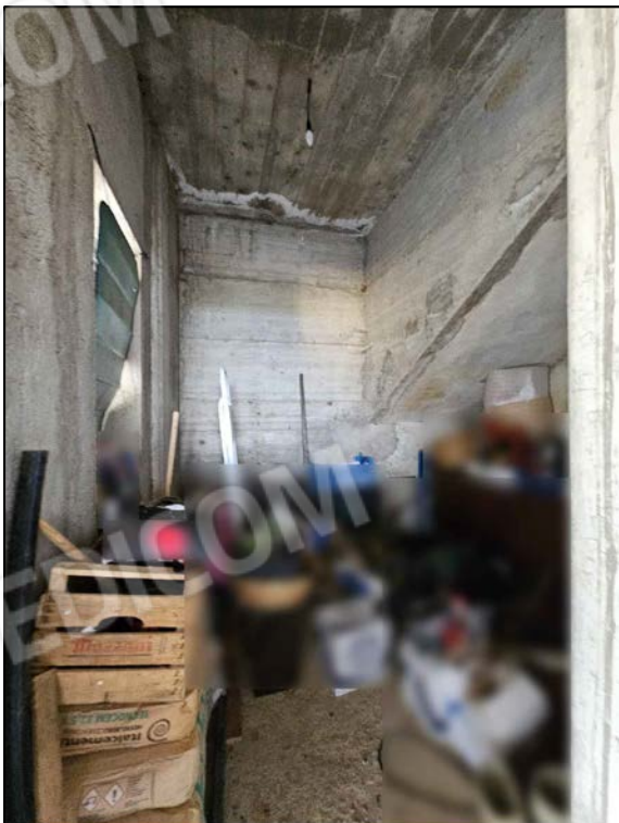
FOTO 21 - Lotto 1 - Corpo A - Locale deposito con accesso esterno
