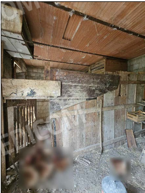
FOTO 54 - Lotto 3 - Corpo B - Interni Piano Seminterrato Sub. 2
