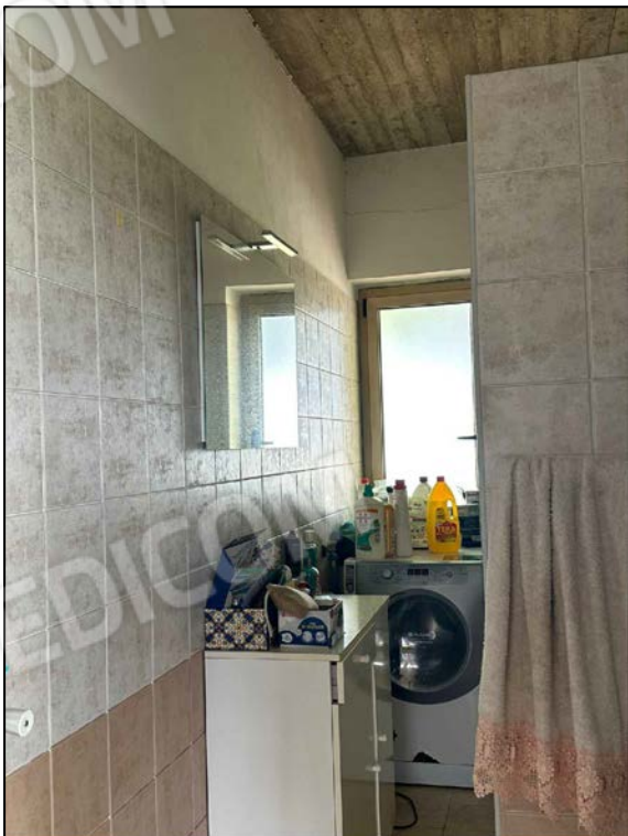
FOTO 39 - Lotto 2 - Bagno all'esterno con accesso dal terrazzo
