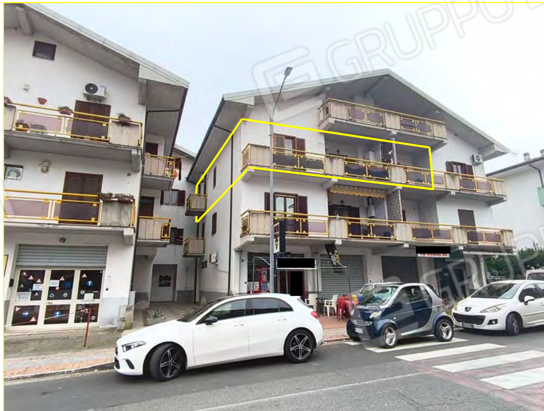
Prospetto Lotto 1 da Via Piano Della Fiera
