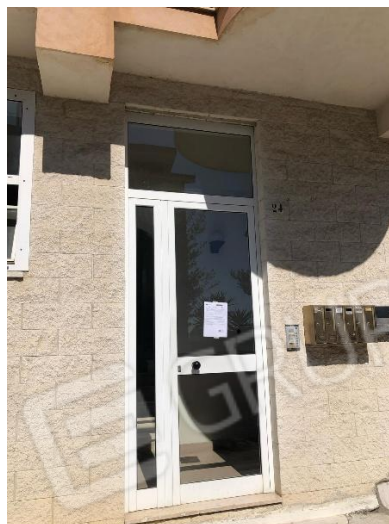
Portone d'accesso al fabbricato
