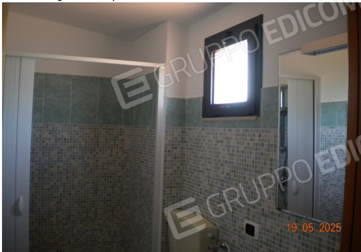
Vista interna bagno al secondo piano sottotetto
