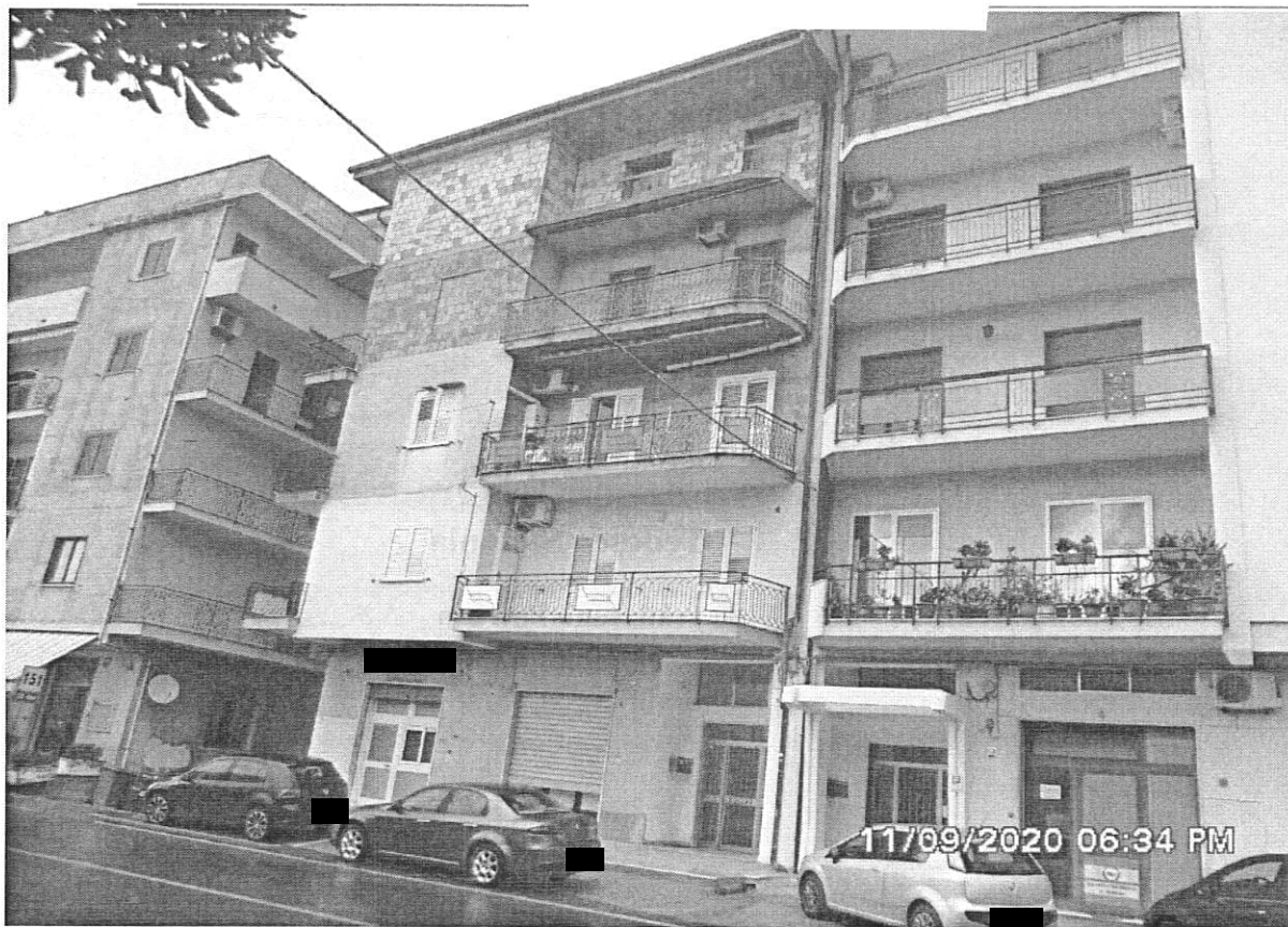
Foto 1. Vista del fabbricato di cui fa parte l'immobile interessato (piano terra)
