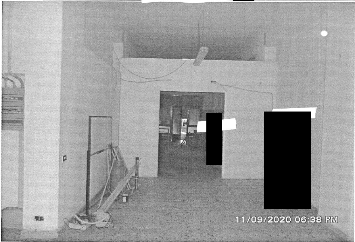
Foto 5. Veduta interna del locale interessato
