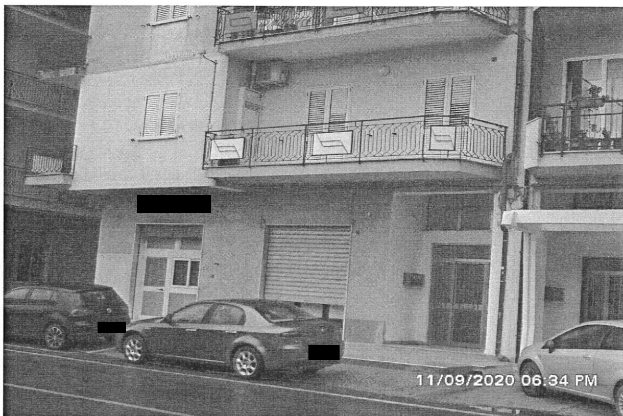
Foto 2. Vista frontale del locale oggetto di controversia ubicato al piano terra
