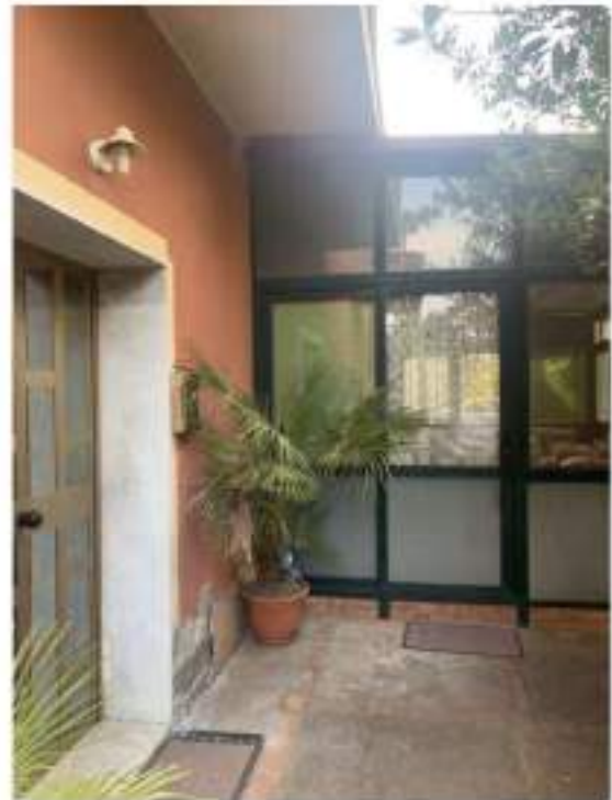
Foto 15- Ampliamento piano terra
