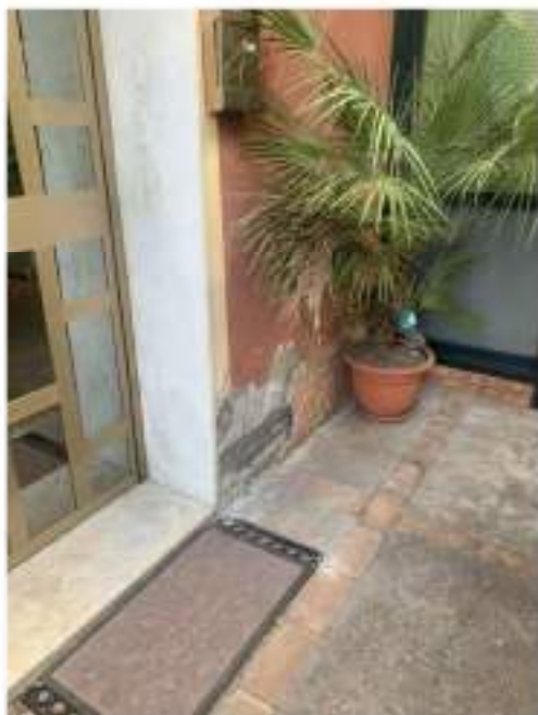
Foto 12 - Vista sulla zona di ingresso
