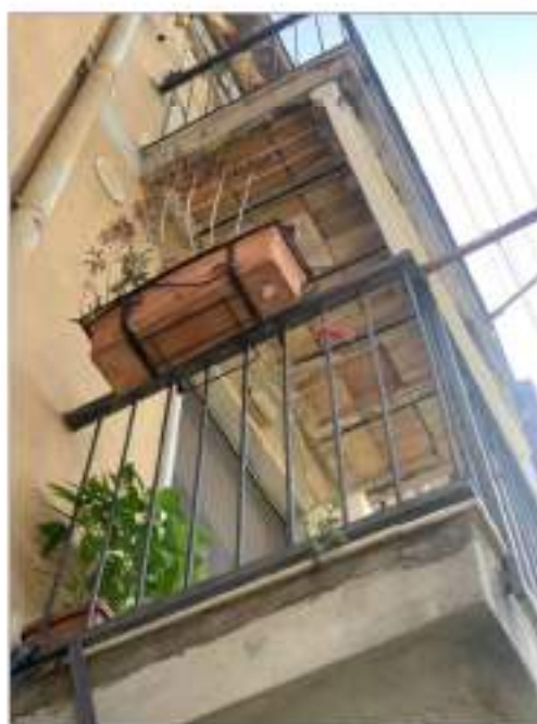
Fig. 11_ Dettaglio facciata posteriore,
