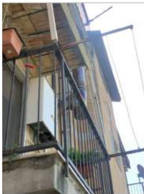
Fig. 10_ Dettaglio facciata posteriore
