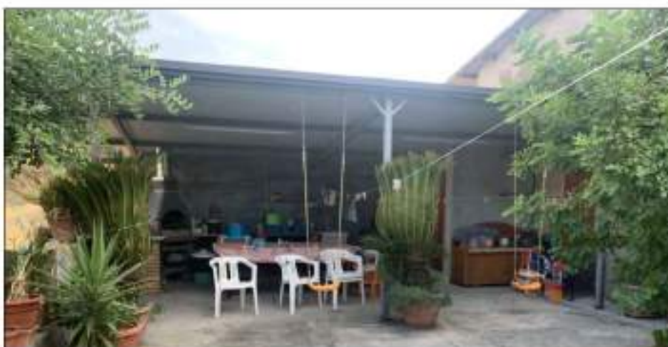
Fig. 25- Tettoia e vano adibito a servizio igienico realizzato sulla corte esterna in aderenza al magazzino sub 3.
