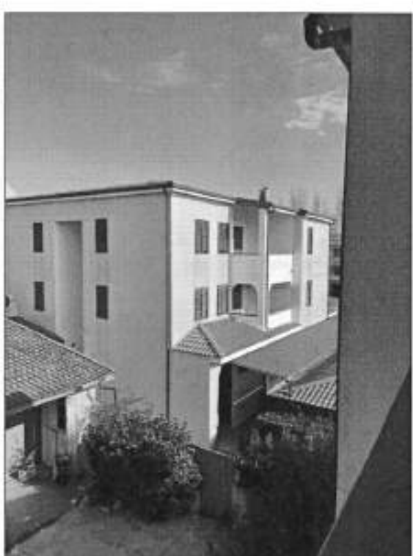
Foto 18 - Fabbricato W, part. 823.
