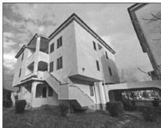
Foto 8 - Fabbricato D, part. 1154.
