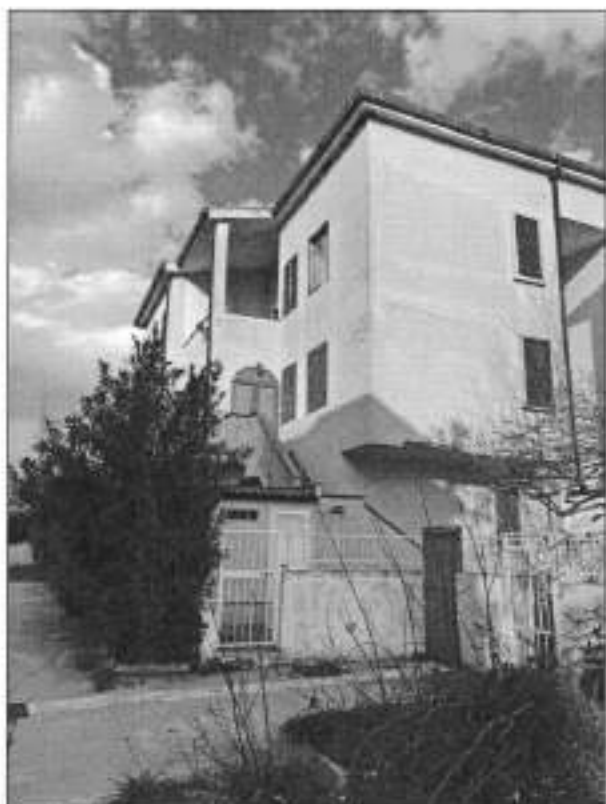
Foto 15 – Fabbricato V, part. 824
