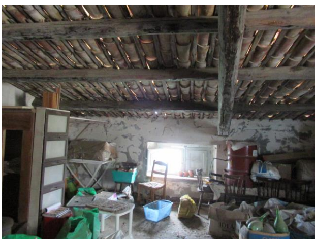
Fig. 18 – Dettaglio – ammaloramento muro perimetrale, coppi mal posati, ecc.
