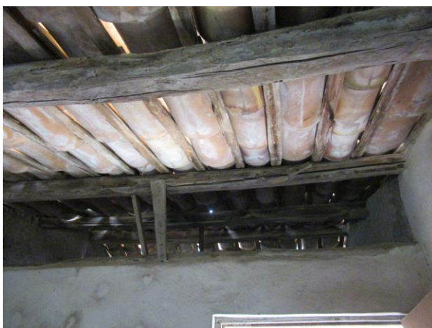
Fig. 15 – Dettaglio travi imbarcate e puntellate.
