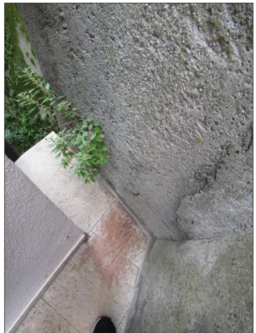
Fig. 9 e 10 – Dettaglio intercapedine con scolo terrazzino appartamento sub 5.
