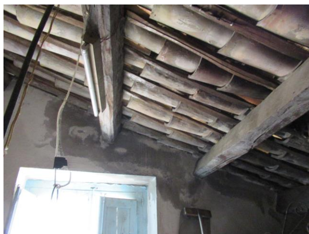
Fig. 16 – Dettaglio – ammaloramento muro perimetrale.
