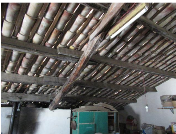
Fig. 17 – Dettaglio –elementi strutturali sia per dimensione che per forma (non a norma).
