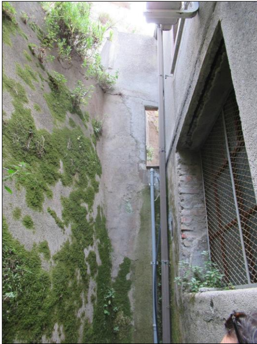
Fig. 9 e 10 – Dettaglio intercapedine con scolo terrazzino appartamento sub 5.
